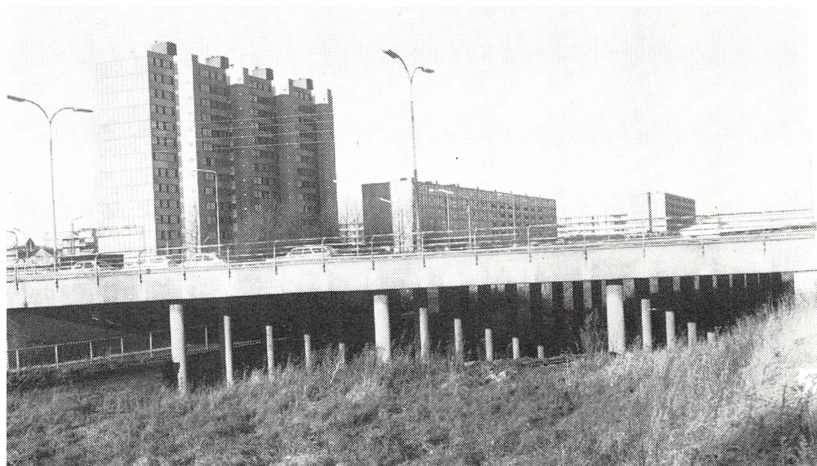
Viadukten for Klampenborgvej.
