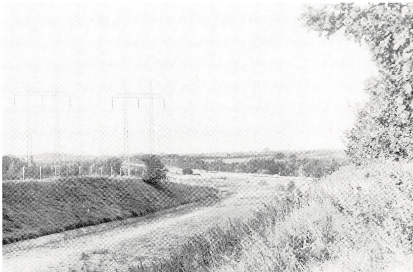
Kurven nord for Lundtofte, hvor banen støder til motorvejen, som den følger parallelt fra Mølleåen til Nærum.
