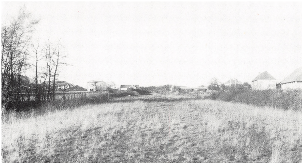
Den nordligste del af det fuldførte jordarbejde ved Nærum station.
