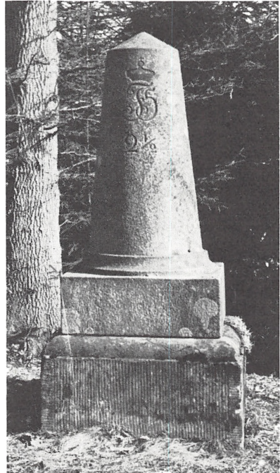
Fig. 11. 2 1 / 2 -milepæl i Rude skov på København-Helsingørvejen. Af granit men stående på soklen fra den ældre marmormilepæl. Skønt opsat ifølge Christian VIIIs resolution 1842 bærer den endnu kronet F 5, ligesom den ældre marmorpæl havde gjort. (K. Uldall fot. 1971).
