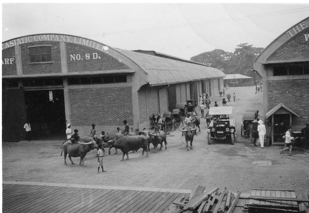
Vandbøfler klar til lastning ved ØK-pakhus Wharf Wat Phraya Krai ca. 1935.
