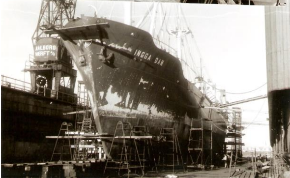
Ø. Inggá Dan ud for Nyhavn, Mestersvig. M. Istønden var monteret bare til denne rejse. N. På Ålborg Værft blev alle plader i vandlinjen udskiftet.
