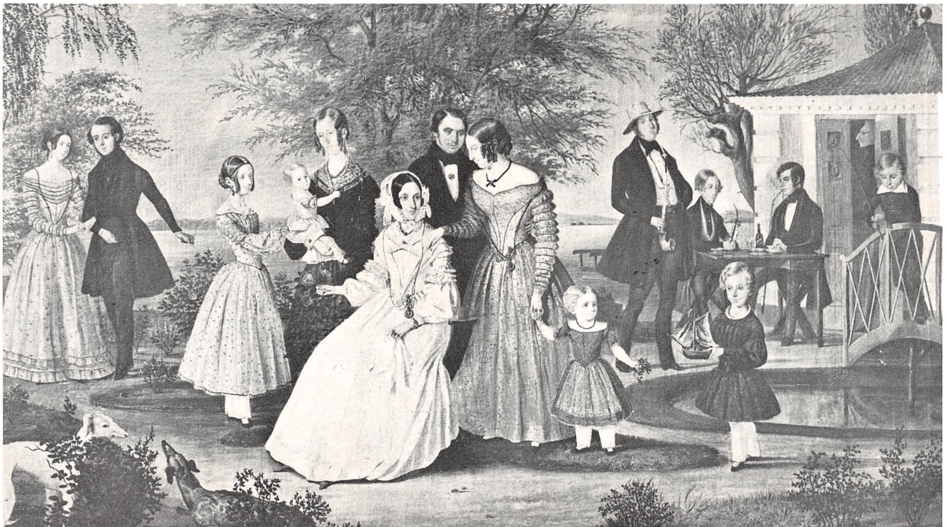
Familien Tøttrup i Dueholms have (nu Grønnegade) 1843.
