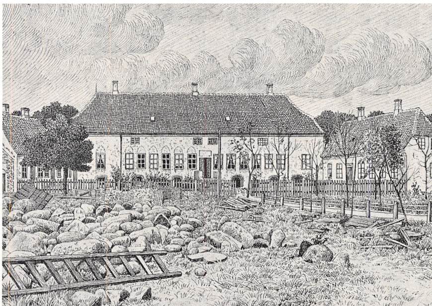
På vej mod forfald. Pennetegning fra 1899 lavet af tegneren Joseph Theodor Hansen i forbindelse med hans arbejde med 3. udgave af Trap Danmark. – De henslængte materialer må stamme fra nedbrydningen af avlsbygningerne.
