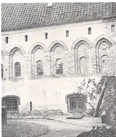
Nøjagtig et år efter var arbejdet afsluttet således, at bygningens sydfacade fremstod i sin oprindelige form.
