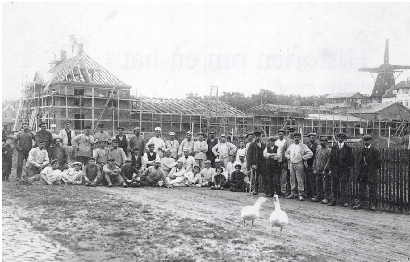
Bygningsarbejderne fotograferet i anledning af rejsegilde 1914.
