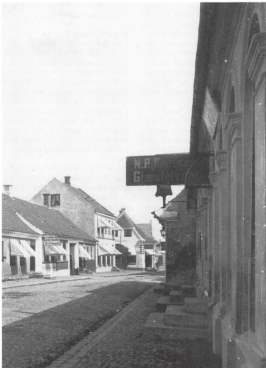
Bager Wachters hus med den flotte facade fra 1858. Foto ca. 1877.
