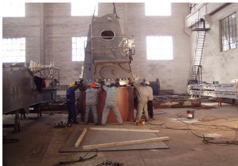
Kranhuset sættes fundamentet. Foto: John Bern.
