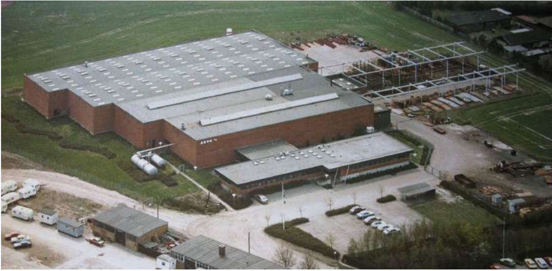
Fabriksanlægget på Industrivej 9 Odense. Foto: Acta.
