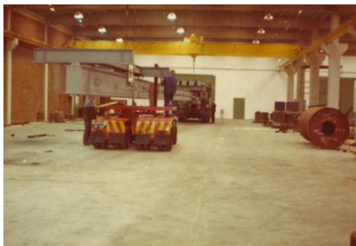
Gantrykranen læsses i et stykke på specialtransport. Hækrollen til højre i billedet er til Lorentsen i Brasilien. Foto: Privat.
