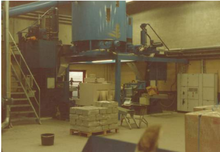
Kompakteringsanlægget monteret hos Kara. Foto: Privat.
