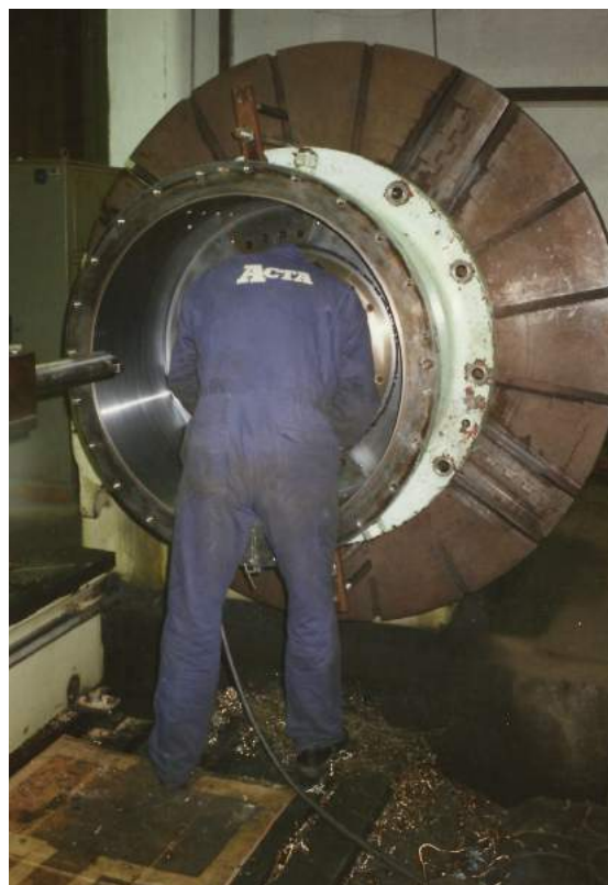
Sten Fejer ved at isætte nyt bundleje i styremaskinehuset. Foto: Privat.
