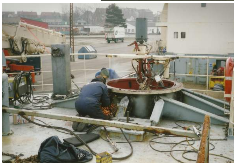
Fundamentets revnede svejsninger repareres. Foto: Privat.
