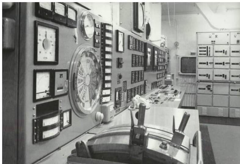
Manøvrepanel og alarmtavle i maskinkontrolrummet. Foto: A.P.Møller
