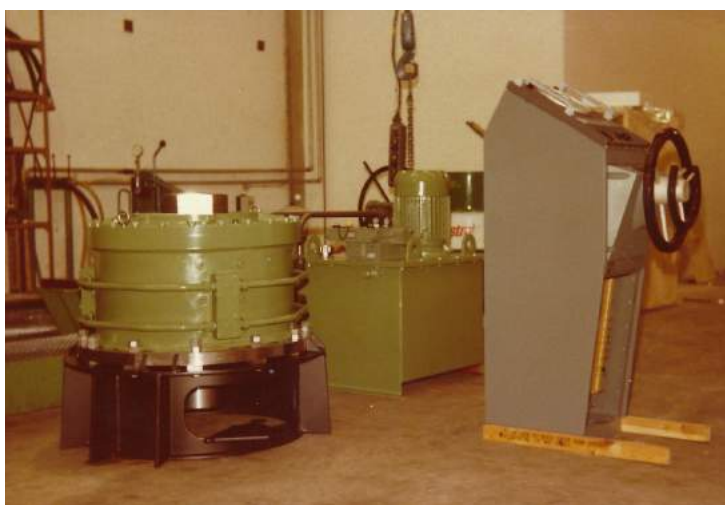
Opstilling af styremaskineanlæg, agterapparat, pumpestation og styresøjlen. Foto: Privat.
