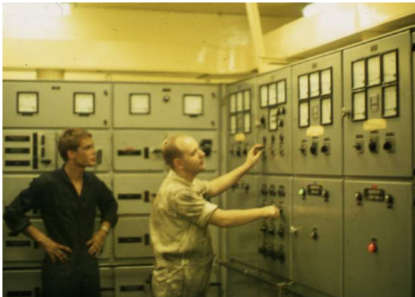
Maskinassistent Anker Drejer instrueres i at sætte generator ind på hovedtavlen. Foto: Privat.
