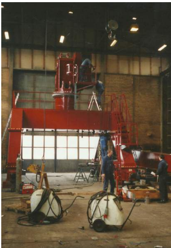
Montage af kranen hos M+T. Foto: Privat.
