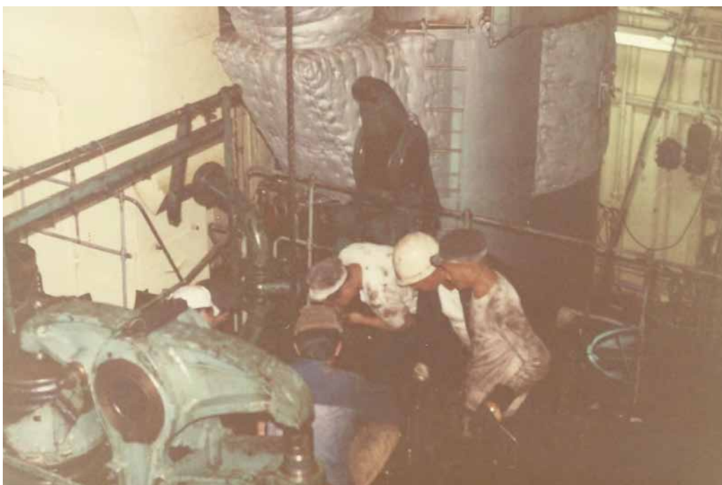
Gæng fra Brigantine Service assisterer med stempeltræk, i forbindelse med vore problemer med stempler og cylinderforinger. Hovedmotoren er en B&W 9-cyl.dieselmotor type: 984-VT2BF-180. Det vil sige med en stempel diameter på 840 mm og en slaglængde på 1800 mm. Foto: Privat.
