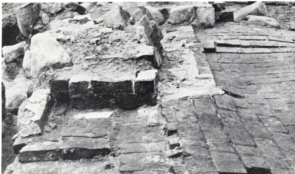
Fig. 2. Døråbning i kirkens nordmur, nær korsgangens sydvesthjørne. Tærsklen er belagt med munkesten, som har været ret stærkt slidte, inden en blændmur er blevet opmuret i den inderste dorfals. T. h. korsgangens munkestensgulv.
