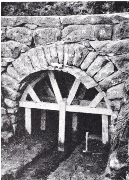
Fig. 4. Gamle Skæremølle bro set fra vest under restaureringen. Den støttende skabelon, hvorover kilestenene blev lagt, er endnu på plads, og stenenes numre kan stadig ses. Johs. Hertz fot.
