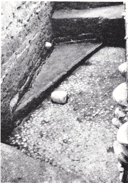
Fig. 7. Gulv i terrazzoteknik med små stykker af hvid kalkspat lagt i ler. Omkring 6000 f. Kr.
