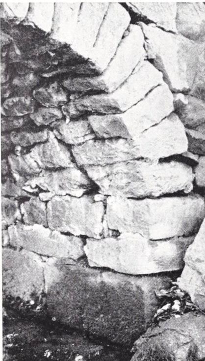
Fig. 6. Udsnit af brobuen på Gamle Skæremølle bro set fra vest. Foruden ses de store kvadre, der muligvis er hentet på byggepladsen på Frederiksborg. Johs. Hertz fot.
