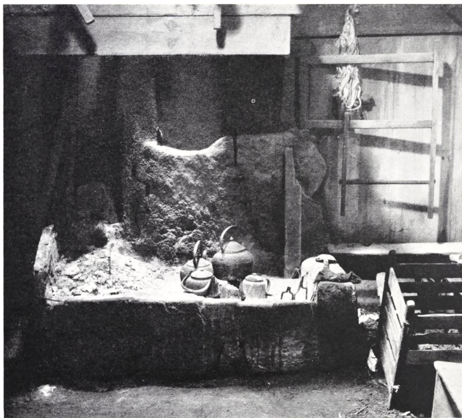
Fig. 6. Det store stensatte ildsted, grúgva, er nu kun bevaret et sted på Færøerne: i den fredede Dúvugarður i Saksun på Streymoy. Over ildstedet ses røgastrækket, som her er forsynet med en drejelig bom, hvori grydekrogen er ophængt. Holger Rasmussen fot. 1949.
