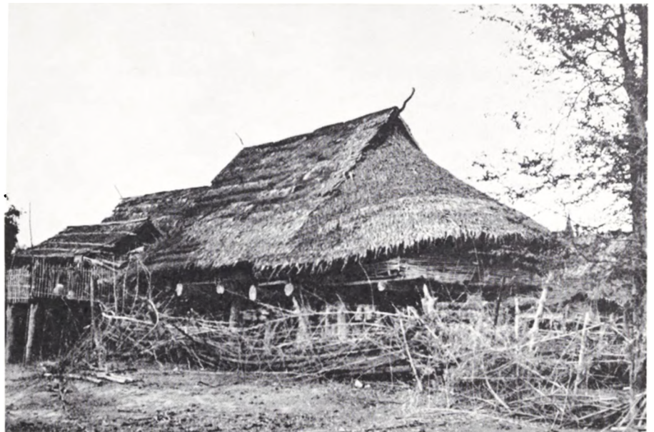
Fig. 11. Yngre ca. 30 år gammelt hus fra Lao-song landsby i nærheden af Uthong i Suphanburi provinsen. Bemærk de svære, runde bjælker, der bærer boligplatformen. De hviler i et Y, hvor en sidegren er skåret af de træstammer, der fungerer som tagbærende stolper. (Fot. Per Sørensen.)
