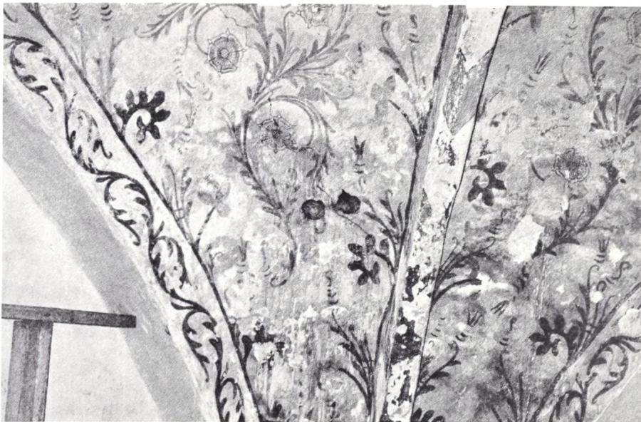
Fig. 2. De sydvestlige kappellige i tredje fag før restaureringen. De var stærkt beskadiget af fugt, saltforvitring og snavs. (Robert Smalley fot.)
