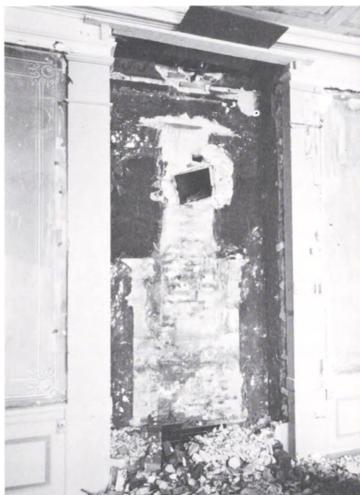
Fig. 8. Undersøgelserne af kachelovnspladsen midtfor på nordvæggen. Billedet viser kachelovnspladsens stadie 2 med en retvinklet muret niche med sporene efter en muret kachelovn.
