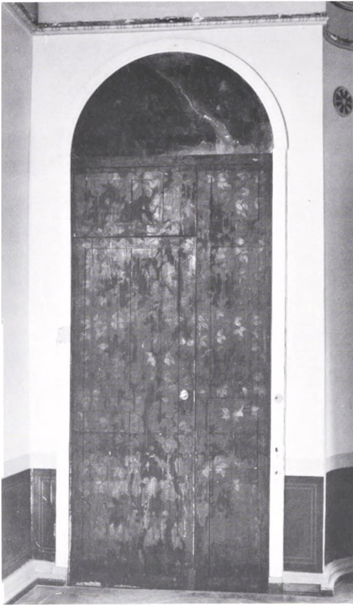
Fig. 16. Havestuen, sidelysoptagelse. Den venstre niche med spor af en oprindelig dekoration bestående af et i jernblik udskåret ferskentræ, der har været loddet på bagsiden af et foranliggende gitterværk.
