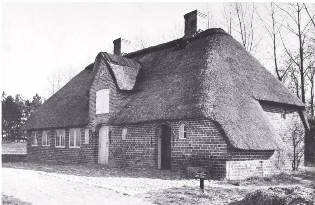
Fig. 1. Knipleskolen fra Nr. Sejerslev er på Frilandsmuseet indrettet, som huset så ud omkring 1870. Bygningen ligger på museet over for gården fra nabolandsbyen, så det er let at sammenligne forholdene de to steder. I sællesskab giver bygningerne et godt indtryk af syd-vestjysk byggeskik. A. R. Nielsen fot. 1974.
