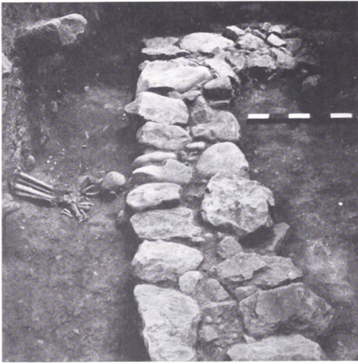
Fig. 7. Fundamentet i den østlige mur af det rektangulære hus nord for apsiden. I 20 m V profilen som ses til venstre, syldsten fra det højereliggende geometriske apsishus og fødderne og skinneben af et lig (se fig. 4).
