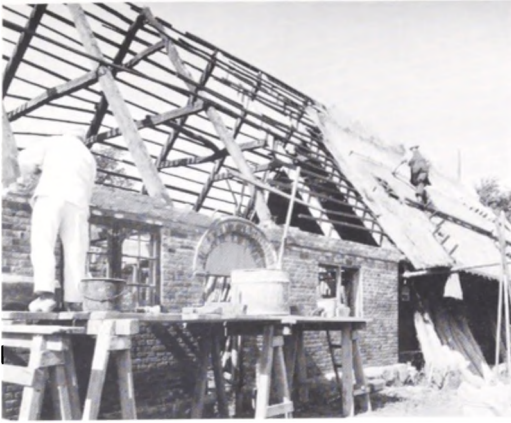
Stuehuset fra Barsø er her ved at få muret gesims, medens der tækkes over stalden.
