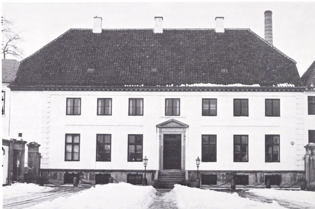
Fig. 1. Brede Hovedbygning før restaureringens påbegyndelse i 1970. Det fremgår, at hele murplanet er hvidkalket, medens hoveddøren og vinduerne er malet vogngrønne.
