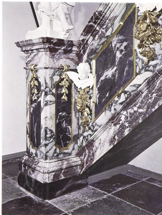
Fig. 21. Detalje af prædikestolens opgang efter restaureringen.
