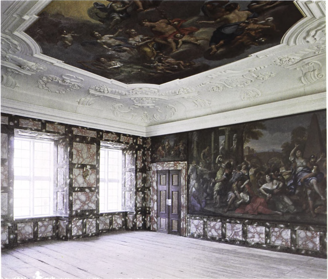
Fig. 8. Riddersalen efter den i dag foretagne restaurering bestående af istandsættelse af stukloftet, rensning og mætning af træværkets marmoreringer og ådringer samt en genopsætning af Hendrik Krocks loft- og vægmalerier.
