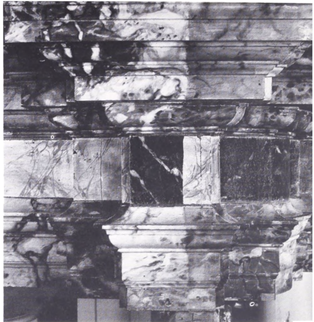
Fig. 13. Allertavlen. Detalje af gesims og arkitrav. I midten ses en rense- og afdækningsprøve. Harsdorffs lyse marmorering i frisefeltet er fjernet. Den uovermalede marmorering øverst og nederst til venstre er befriet for det gulfede laklag.
