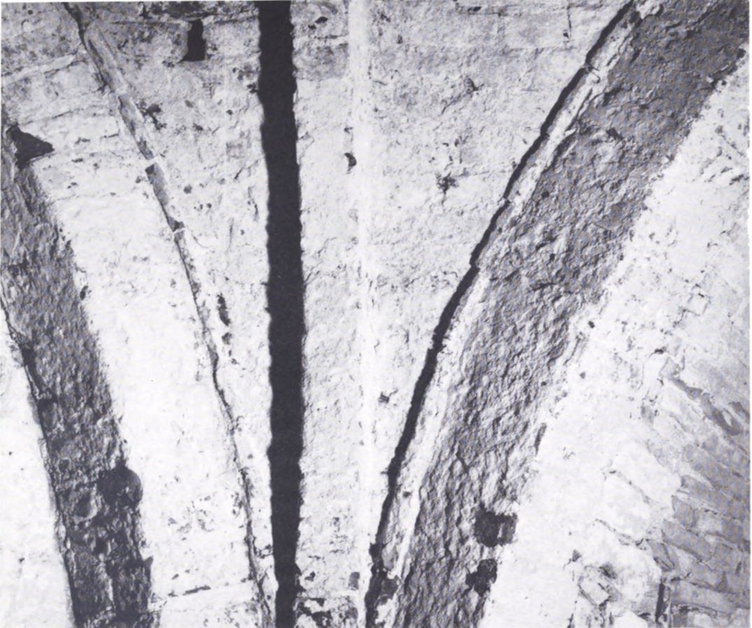
Fig. 16. Korets hvælv efter at den hårde cementpuds er hugget af. Op langs skjoldbuerne ses kanten af de indmurede fliser.
