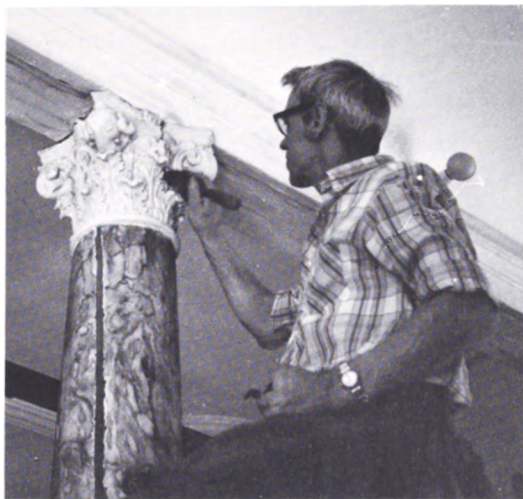
Fig. 22. Udfyldning af revner i udenværker-nes søjler og kapitæler. Den mørke stribe i søj-len viser revnens bredde. Jan Brøndsted fot.
