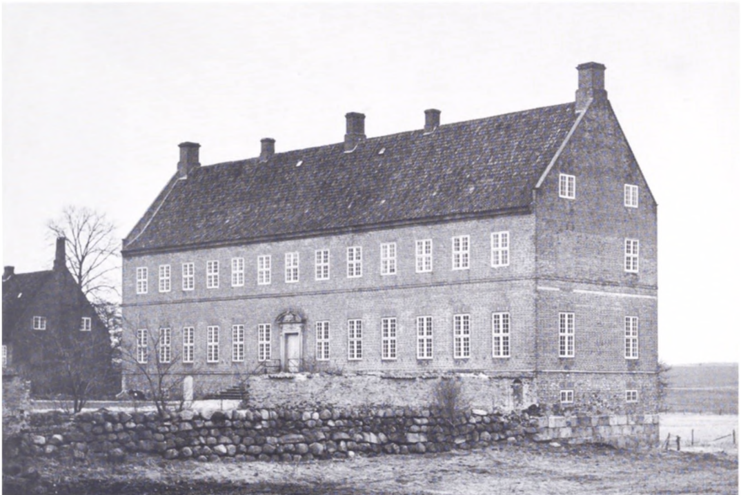
Fig. 1. Selsø hovedbygning fotograferet 1972. Borggården er dækket af et 10–30 cm lag jord bevokset med ukrudt og småkrat. Dele af hegsmuren er faldet ned.
