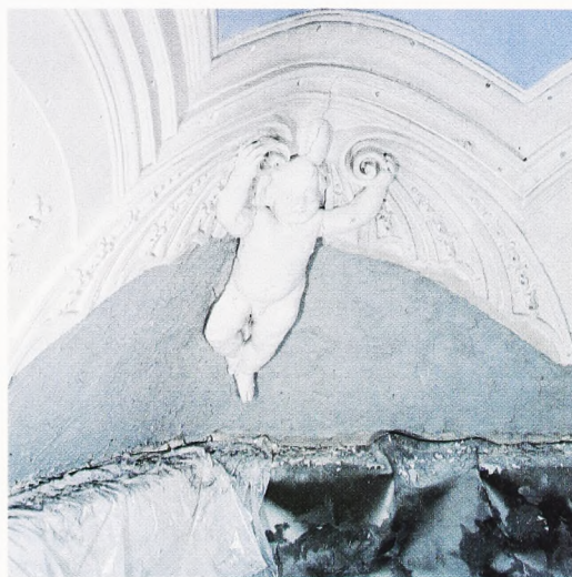
Fig. 11. Kalkmørtel påsat med ske, således at den vandholdige og skeldannende udkastning undgås. Grundet kuplens runding måtte der udføres pudseflader i flere tempi alt efter stilladserne, men ved den omtalte arbejdsgang opstod der ingen svindrevner.
