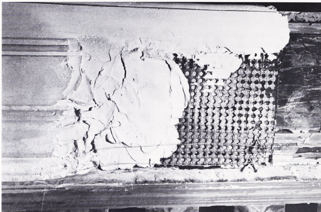
Fig. 12. Profil af galleriets gesims under opbygning. Det påskruede terrakottavæv samt den påsatte og færdigtrukne gips.
