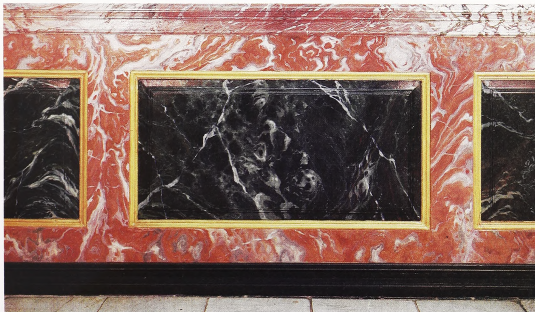
Fig. 18. Færdig marmorering på panelværk.
