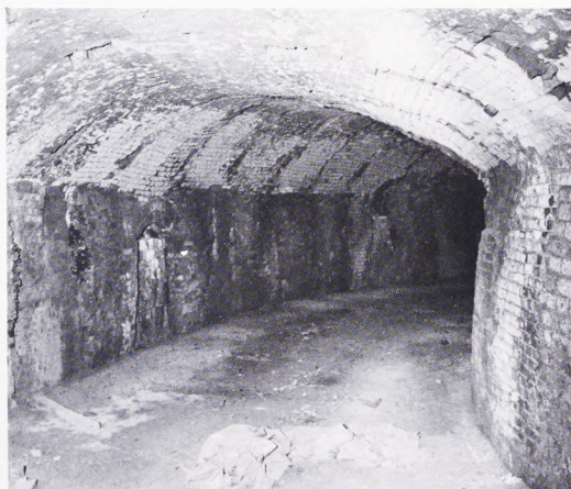
Fig. 2. Nivågård Teglværk. Interiør fra ringovnen som er den ældste – og stadig bevarede – i Danmark opført af dens opfinder Friedrich Hoffmann i slutningen af 1860'erne. Torben Ejlersen fot. 1978. Industriregistreringens arkiv.
