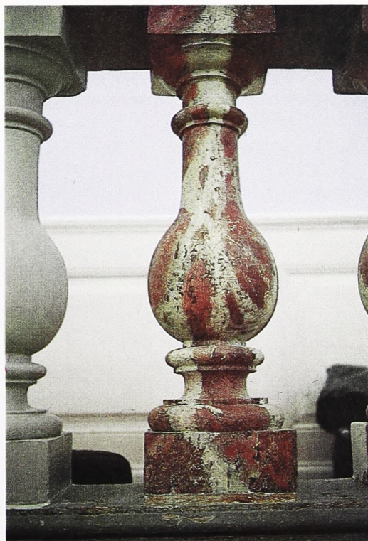
Fig. 14. Nærbillede af afdækningsprøve på balustraden.
