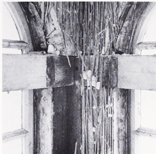
Fig. 8. Lanternens vinduespartier efter nedhugningen af væggenes nyere, defekte pudslag. Ved vinduesrammerne ses metalinddækningen, der bar spor af den oprindelige røde vinduesfarve.
