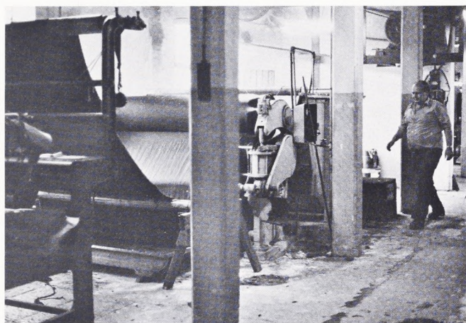
Fig. 6. Fra carboniseringsprocessen. I billedets forgrund kører klædet fra syrebadets vridemaskine op ad en rampe – allerforrest – og ind i carboniseringsovnen.
