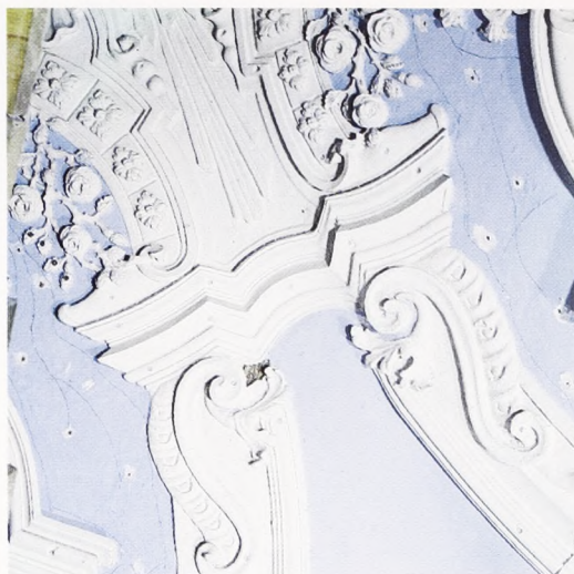
Fig. 7A. Kuppelhvælvet's hjørnefelt. Før restaureringen. Øverst i det blå felt ses det sted, hvor det oprindelige pudsfragment er udtaget.
