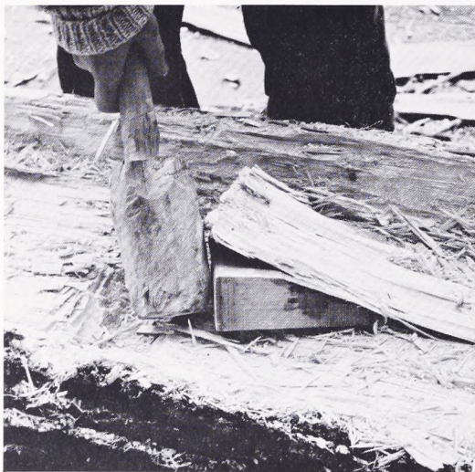
Fig. 7. Afspaltning ved hjælp af kile og kølle.
