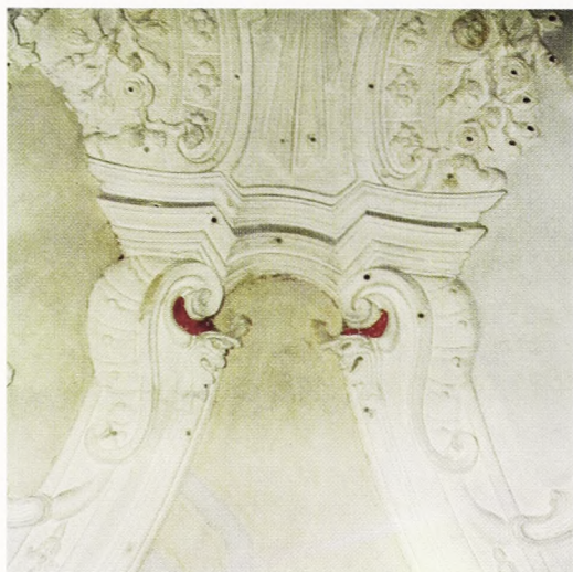
Fig. 7. Kuppelhvælvet's hjørnefelt. Øverst ses det bevarede fragment med den oprindelige røde farve.
