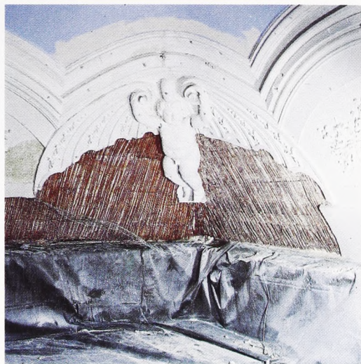
Fig. 10. Påsætning af pudsebærer, rørvæv og galvaniseret trådnet, efter nedhugning og rensning for gammelt puds og rørvæv.
