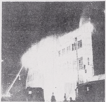
Da Branden i det store Fabrikbygning på Lyngbyvej var på sit højeste. Helt Taget er raseret af den voldsomme Brand.
