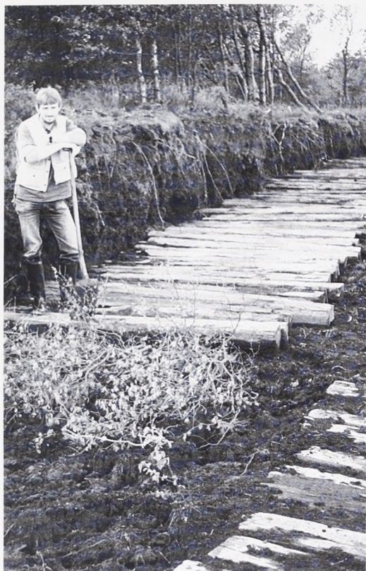
Fig. 5. Tæt ved den 3500 år gamle vej i Speghøje mose anvendes samme byggeprincip i en nutidig arbejdsvej for sphagnumgravning: der lægges et grenlag ud som fundament, på de blødeste steder suppleres med langsgående tømmer og øverst placeres kørebaneplanker. MSJ fot. 1981.
