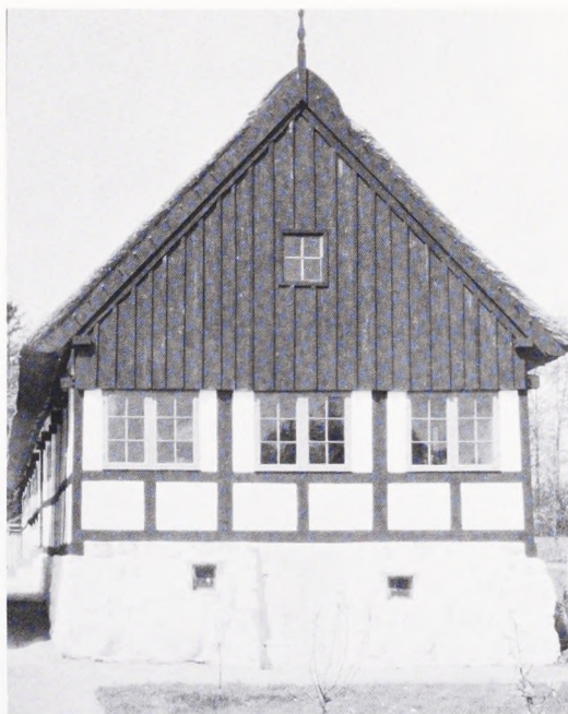
Fig. 4. Stuehusets østgavl. Den stensatte fodmur under gavlens bindingsværk er næsten 1,5 m høj. Døren fører ind til kælderen under salen, hvis vinduer på hjemstedet vendte mod havet.
