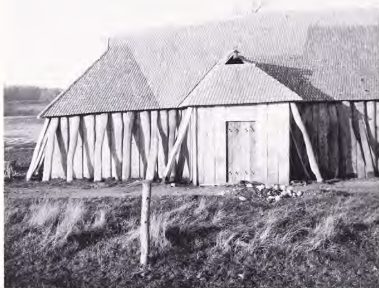
Fig. 7. Tagfladerne dækkes af små tilspidsede egetræsspån, graterne dækkes af vindskeder udhugget i et vinkelformet tværsnit, og taget krones af en høj »kam«. Hvor vindskederne og kammen mødes, er der endnu ikke opsat kugler med brandstænger. H. S. fot. november 1984.
