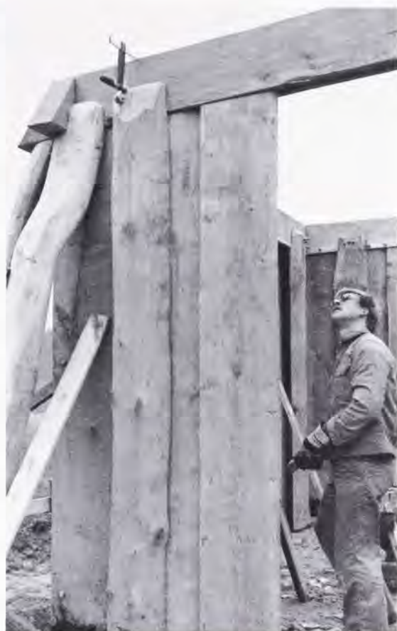
Fig. 4. Vægplanker og skræstivere opstilles efter tilpasning til de allerede oplagte hammerbånd. H. S. fot. november 1982.
