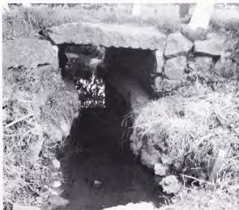
Fig. 3. Holmegårds bro under den gamle Randers-Hobro-landevej, ved vestenden af Glenstrup sø. De halvrunde isrygge på bropillerne er usædvanlige. Tanken ledes hen på, om der kan være tale om genbrug.
