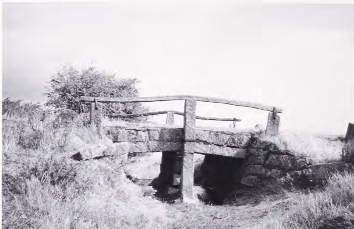
Fig. 2. Immervad bro. Opført 1786. Brodækket består af stenplanker, som er ca. 4 meter lange. Den eksisterende bro afspejler en tidligere konstruktion af træ.
