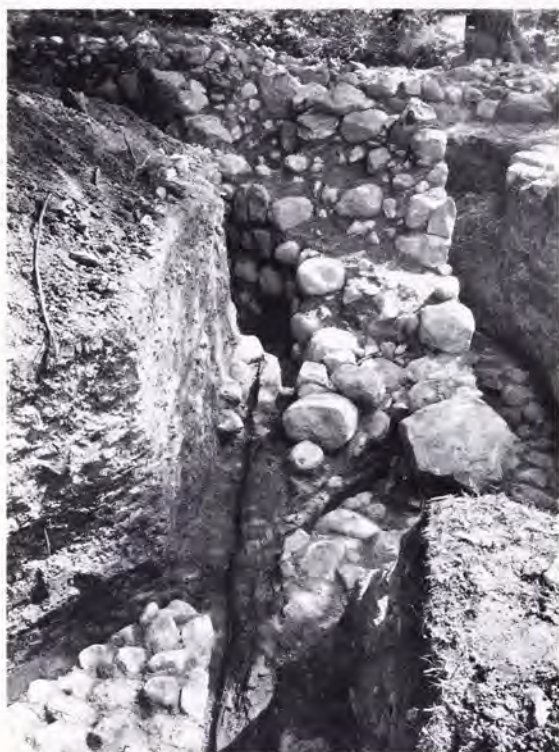
Fig. 7. Fotografi fra 1929, optaget af C. M. Smidt. Billedet viser den kraftige tømmerkonstruktion i det ottekantede tårn (syd-vestre afsnit) samt resterne af tårnets murværk af kampesten. I forgrunden er tårnet revet så langt ned, at fundamentet mellem tømmeret ses, men i baggrunden står tårnmuren tilbage i ca. 2 m højde.
