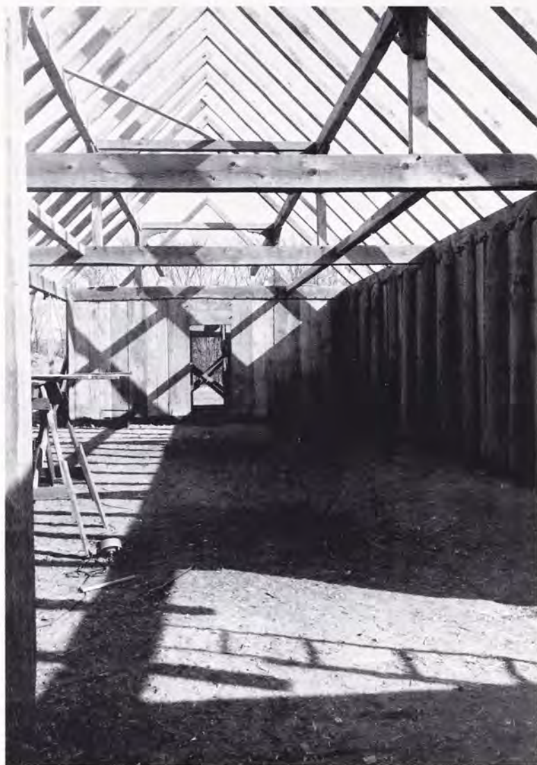
Fig. 5. Sideåsene er oplagt på dværgstolper opstillet på bindbjælker, og samlingerne er forstærket med »knæ«. H. S. fot. marts 1984.
