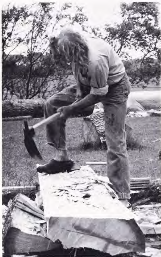
Fig. 3. Tilhugning af planke med skarøkse. Tømrernes arbejdsstilling blev siden mere hensigtsmæssig, idet tømmeret blev lagt på bukke og vipet op, så huggene kunne føres omtrent lodret. H. S. fot. juni 1982.
