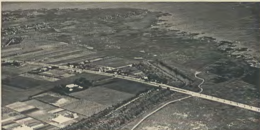
Luftfoto af arealerne ved Avedøre Kaserne 1945, bemærk skydebanerne ved vandet
