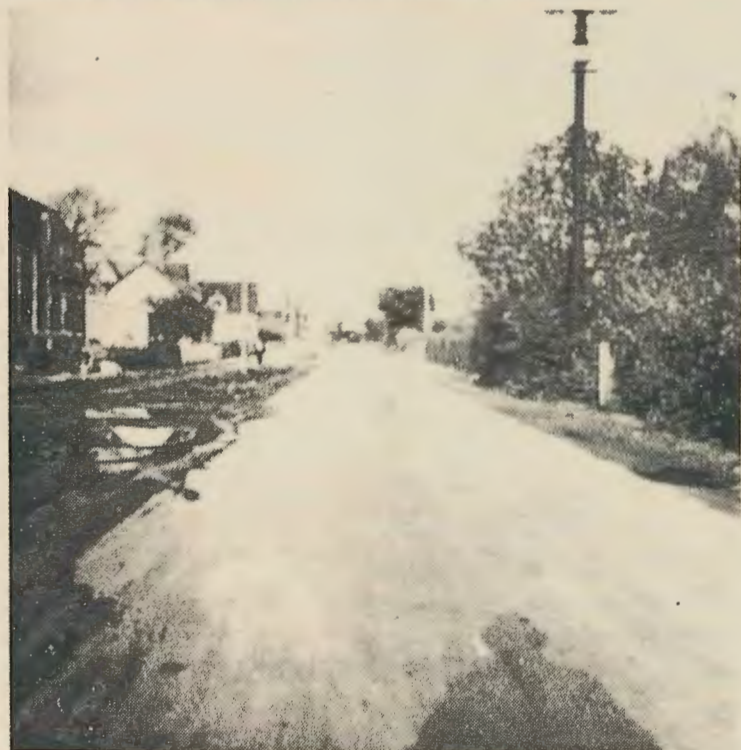
Hvidovrevej med udsigt mod nord fra Landlystvej 1938
