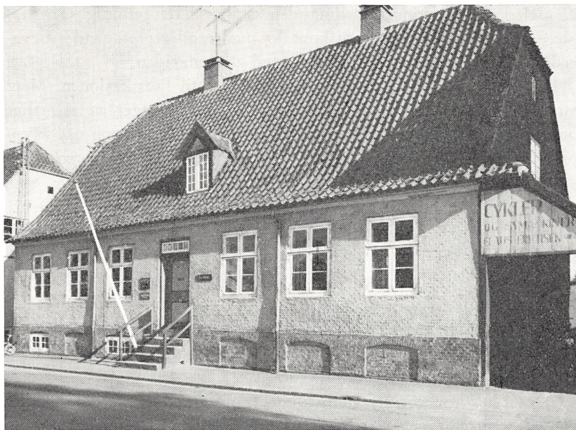
Lindegade 44 i Christiansfeld. Huset er bygget 1781 af Abraham Goll. I gården findes en yngre værkstedsbygning. Her havde pottemageriet og kakkelovnsjæbrikken til huse. (Foto: Det særlige Bygningsyn).
