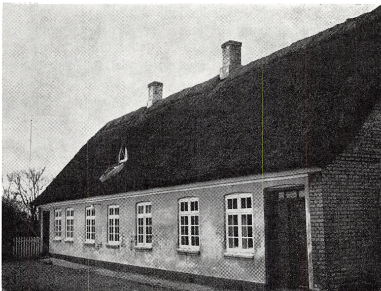
V. Ulslev skole (sydfacade) er forlængel og nye døre indsat. Bueslag over vinduerne er bevaret.
