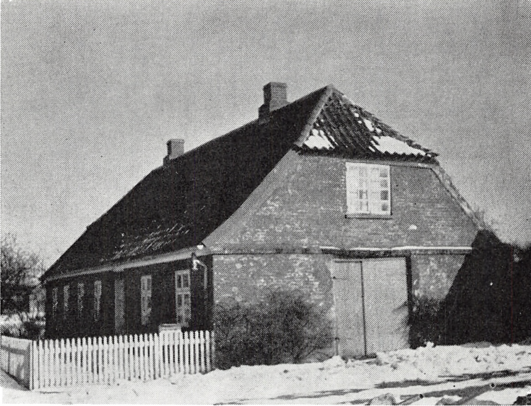
Egelev skole (fra nordvest) har væsentlige ligheder med V. Ulslev skole. Dog sidder den ny dør på oprindelig plads, men det kan ses, at indstiftelsestavlen ved dørens fornyelse er nedtaget.
