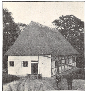
27. „De gamle Huse“. Museet i Maribo. (Fot. O. Bager).
