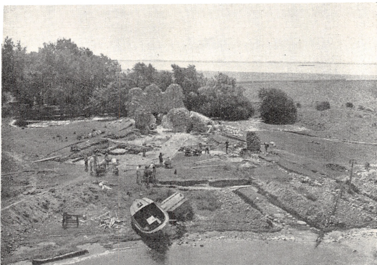
Udsigt over Værftsarealet. Beddingen til højre i Forgrunden. Bjælken til venstre er fra Beddingens Tømmerkonstruktion (det er en af de tværgaaende Støttebjælker). Stedet er gennem mange Aar blevet benyttet af Omegnens Fiskere til Reparation af Baade, da der er dybt Vand ind til Land, saa man let kan faa Baadene op.
