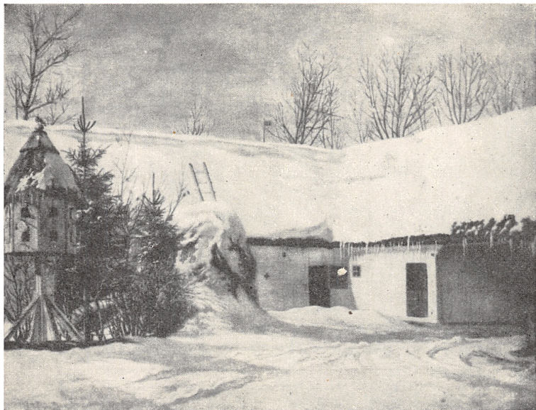
Rubbelykke Præstegaard ved Vintertid. Længen til venstre, der var Forpagterbolig, nedbrændte 4. Oktober 1940. Efter Maleri af Georgia Clausen-Bagge.
