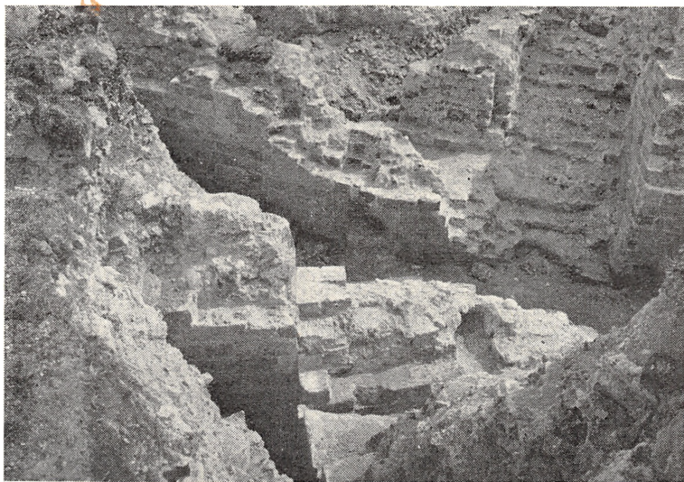
Forbindelsen mellem Taarn og Flankemur. Man ser den ene Sten, der giver „Fortanding“ mellem de to Afdelinger. (Venstre Flankemurs Forbindelse med Taarnet).
