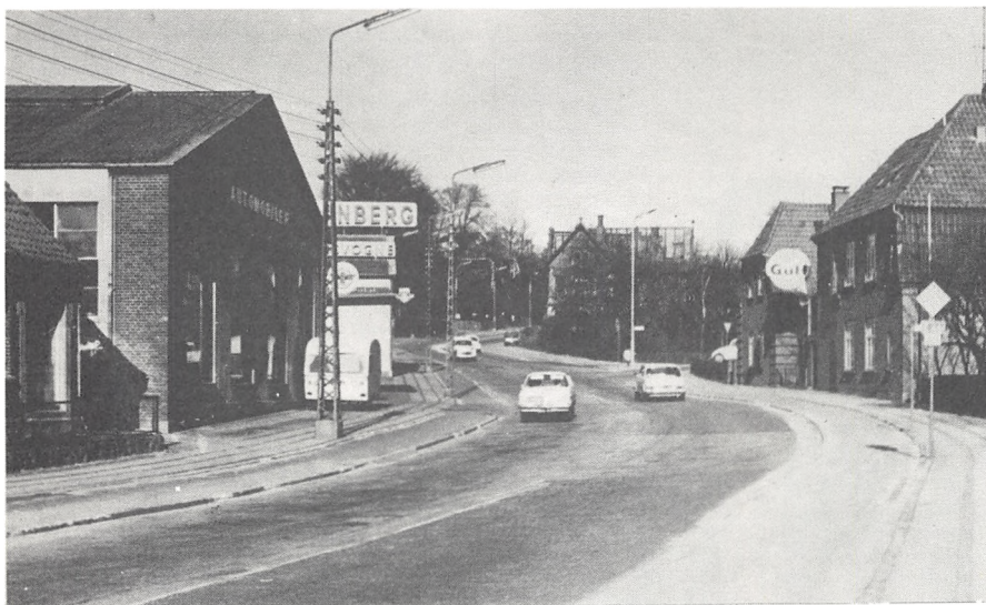
De to huse til højre i billedet - også på Fynsvej - som lå nærmest op til Svineryggen, var de sidste, der faldt, for at den nye vej kunne færdiggøres.
