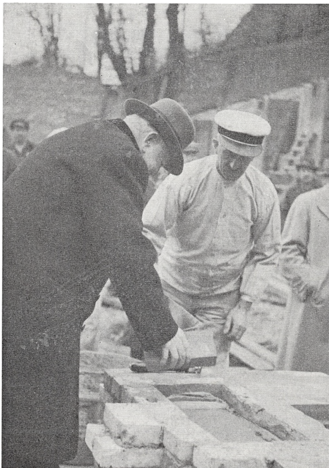
Grundstensnedlæggelsen 22. november 38: Jens Holm nedlægger den første sten.
