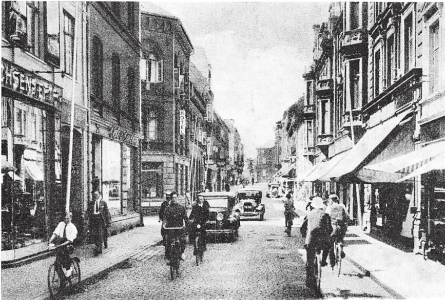
Højskolehjemmets bygning i Jernbanegade.
