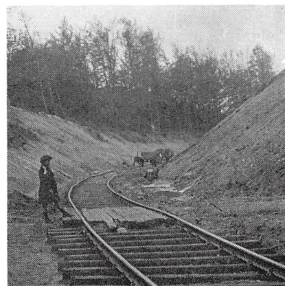
Fra Trolldhebanens anlæg 1917.
