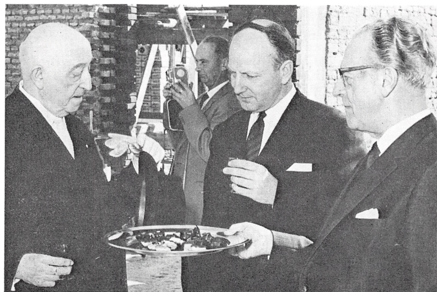
Fra grundstensnedlæggelsen til Handelsskolens nye bygning den 11. September 1962. Købmand Holger Kelstrup og skolens direktør, R. W. Crüger.
