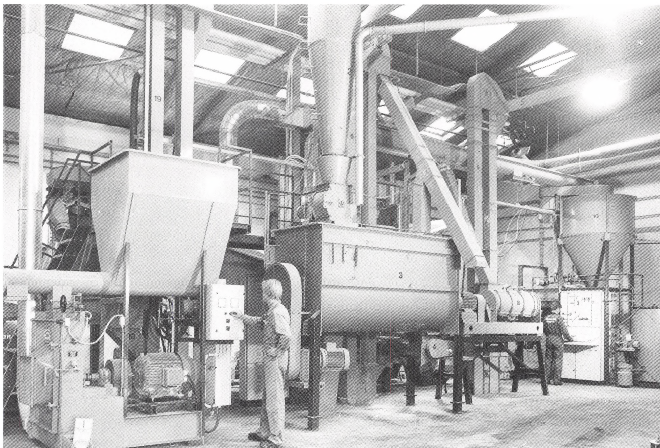
Teknisk Anlæg, foderstofhallen 1983.
