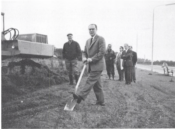
Alex Jentsch tager det første spadestik til forbrændingsvarmeværket på Kløvervej den 11. oktober 1968. Foto: Egon Jacobsen.
