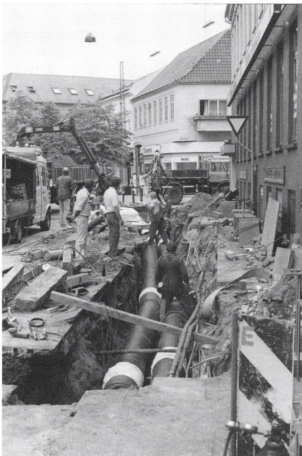
Renovering af fjernvarmerør, Rendebanen maj 1988.
