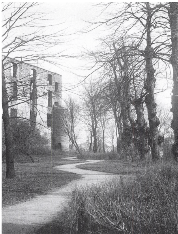
Det sydvestlige hjørne af Koldinghus, hvor »fangehullet« var.
