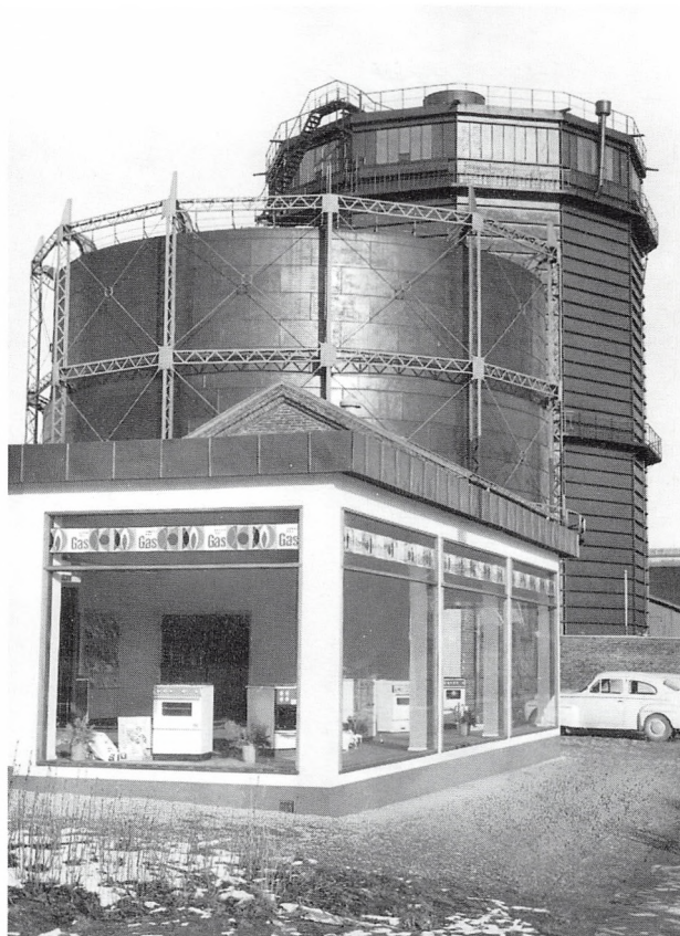
De to gastanke og gasværkets udstillingslokale, 1961. (Foto: N. Lisberg)
