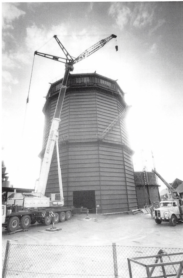
Den store gastank under nedrivning 1991. (Foto: Ludvig Dittmann).
