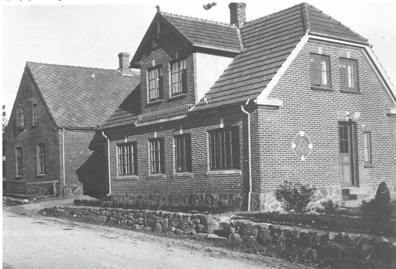
Hjarupvej 11, tidligere Vønsild Elektricitetsværk.
