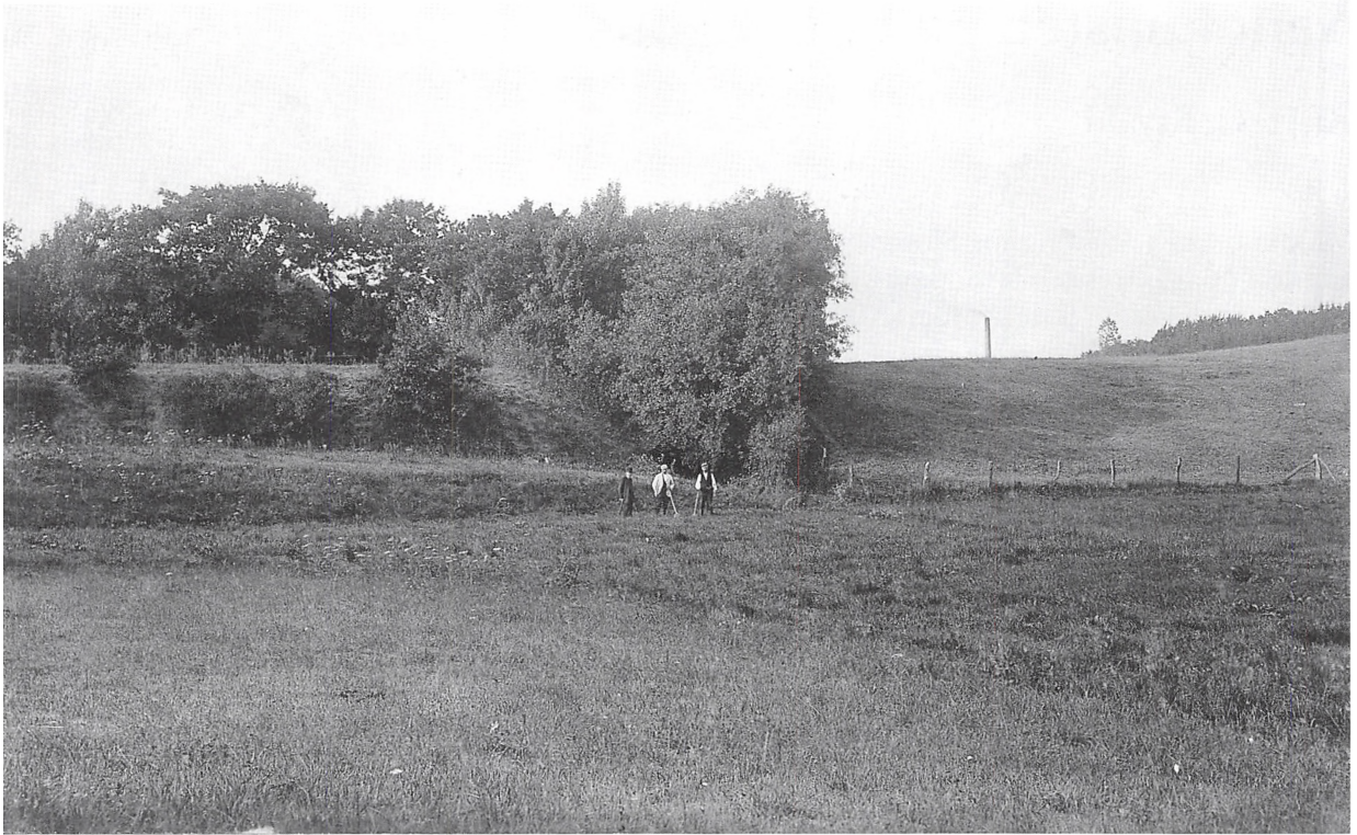
Den nordlige del af Piledammen set fra syd, 1904. I midten skomager P.M. Møller sammen med nogle arbejdere. På det sted, hvor de står, var indløbet til springvandsledningerne til Koldinghus.
