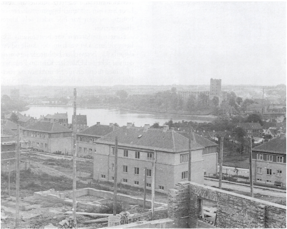
Byggeriet på Sneppevej set mod Slotssøen og Koldinghus.
