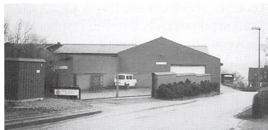
Schmidt & Sønners maskinfabrik i Tved, hvor i dag Diesella har sin Tved-afdeling, 2002.
