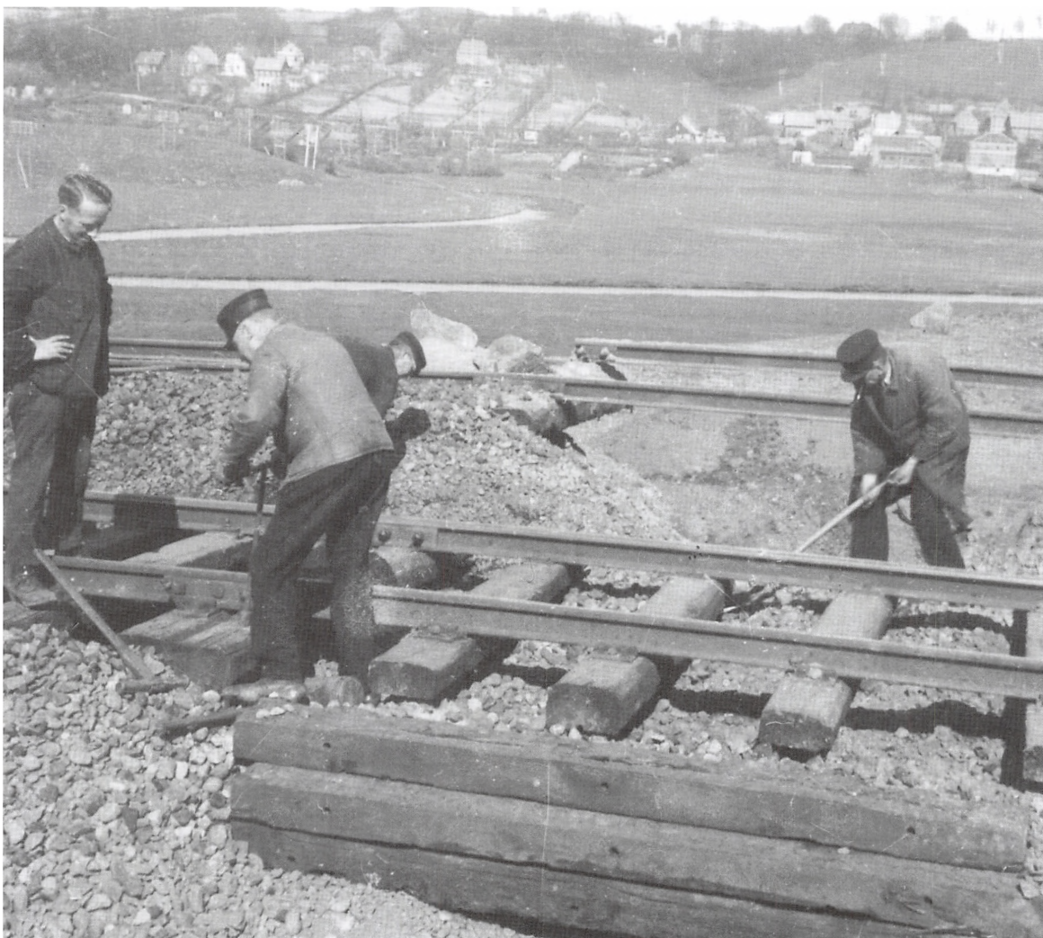
Oprydning efter sabotagen mod jernbanen ved Seest den 7. april 1945, som N.J. Bollerup deltog i. Foto: Holger Hertzum-Larsen.
