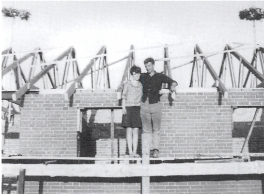
Gerda og Gert Skare ved rejsegildet på Gert Skares første hus i 1968.
