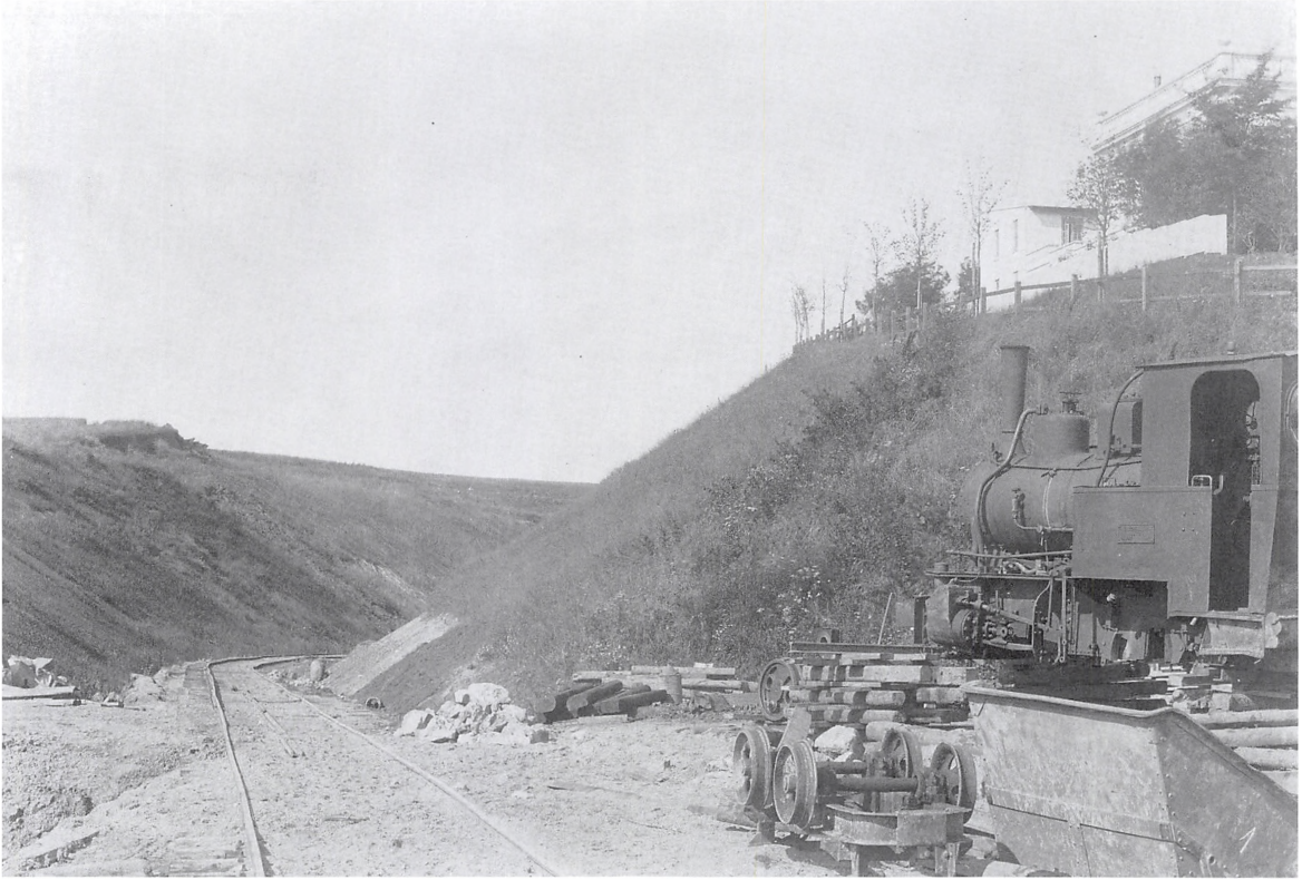
Gennemgravning til Trolldhedebanen ved Ndr. Ringvej. Til højre i billedet ses villaen Fredensborg, ca. 1916.
