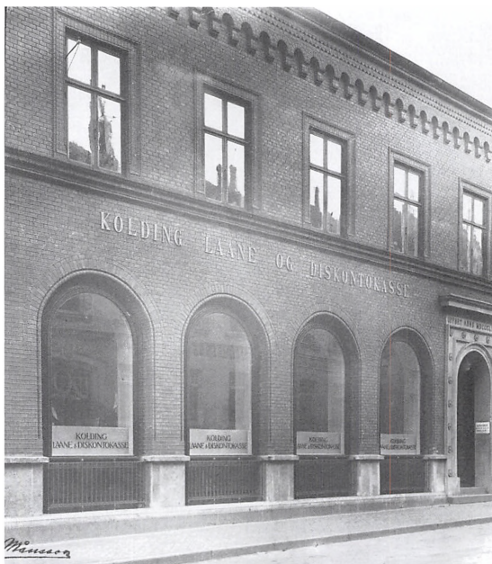
Jernbanegade 22, hvor Kolding Laane- og Diskontokasse i 1885 byggede nyt hovedsæde. I dag har Galleri Avanti til huse i den historiske bankbygning. Foto: Månsson.
