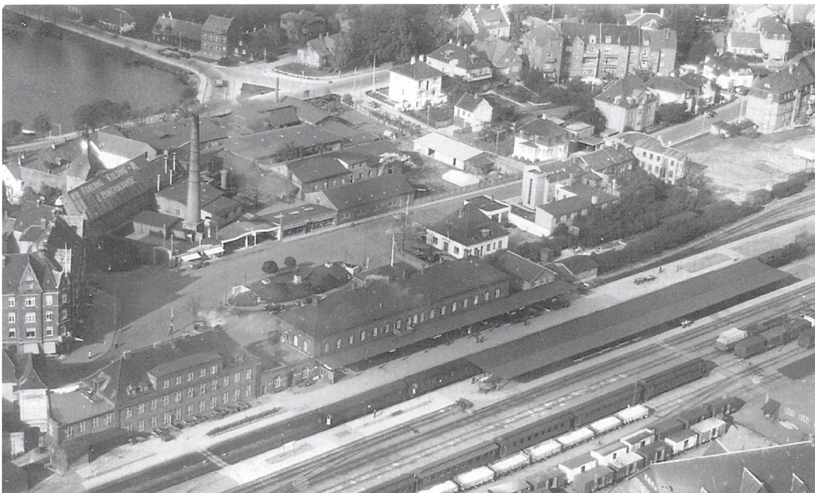
Banegården med posthuset fra 1930 i forgrunden. Posthuset var allerede efter få år for lille, og i 1951 blev det erstattet af en ny bygning på den anden side af banegårdsbygningen. Det gamle posthus fungerede derefter videre som telegrafbygning. I dag rummer den bl.a. Det Internationale Frisørakademi. Foto: "Aero" Dansk Luftfotografering, København.
