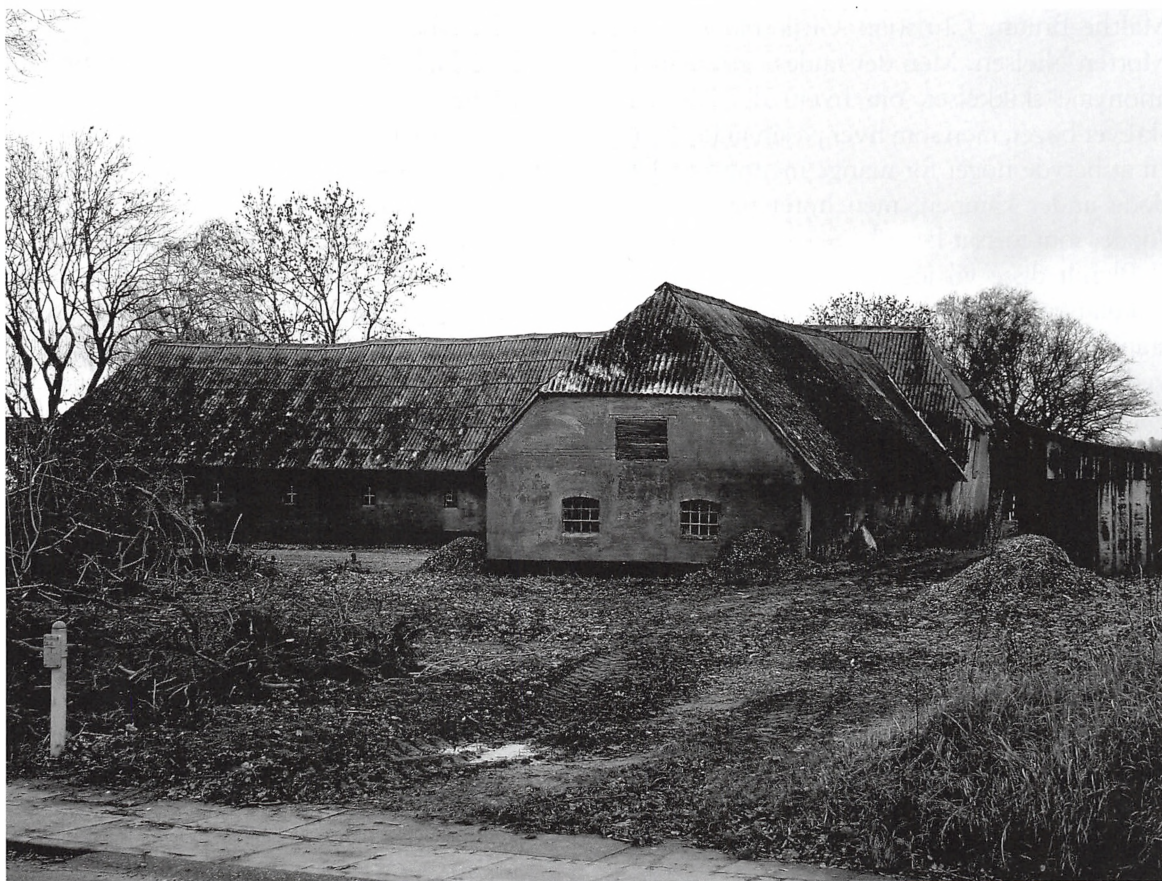
De røde staldbygninger kort før nedrivningen i 2004.
