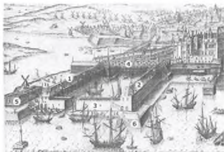
Tøjhushavnen 1611, 1) Tøjhuset, 2) Provianthuset.
