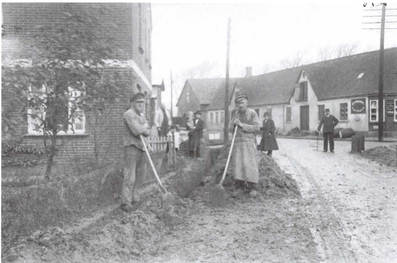
Kloakmænd i arbejde foran Mette Petersens hus i Øster Assels i 1924.
