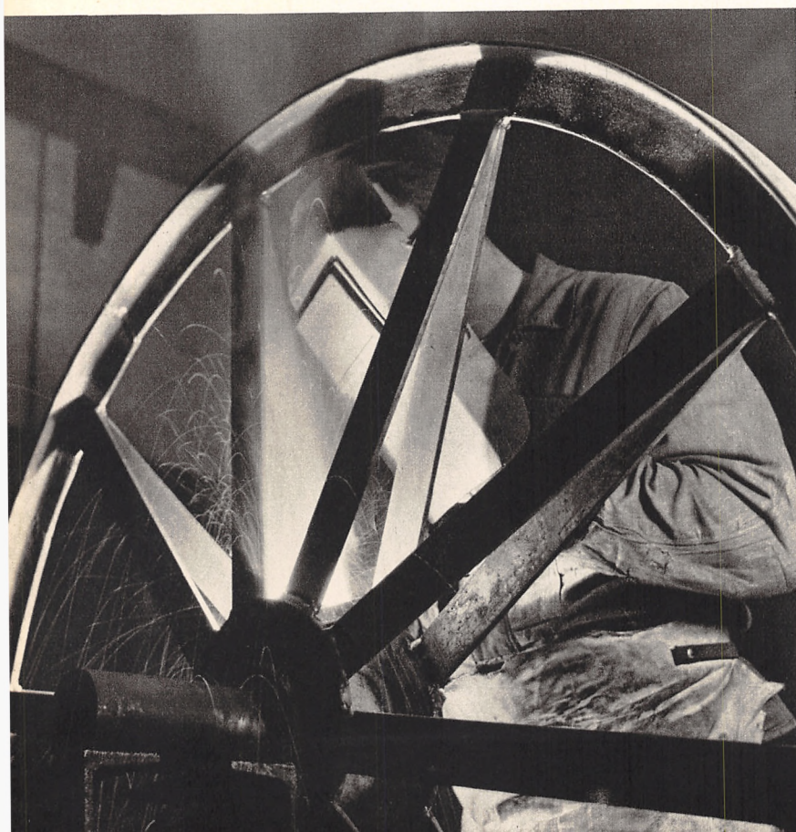
Elektrisk Svejsning af Rat til Haandstyremaskine.
