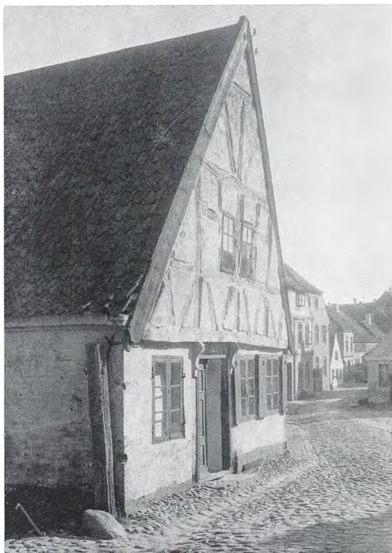
Præstegade, i forgrunden nr. 18A, hvor nu Kloster vænget går ned til Dammen. Præstegades nordside havde en ret blandet social sammensætning, hvilket også fremgår af husene. Bag nr. 18A ses nr. 16 og 14, hhv. førstepræstens bolig og Wilhelmineskolen, og bagved igen en række småborgerhuse. Bag fotografen, dvs. i nr. 20 og 22 lå nogle af byens elendigste huse, hvor en række fattige boede. De ejedes 1803 af farver Barkentin, som selv boede i nr. 18A.
