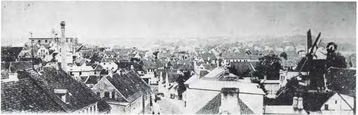
Haderslev set fra syd ca. 1900. Til venstre ses en række af de huse, der i 1850'erne og 1860'erne byggedes langs den nye chausse til Abenrå. Til højre ses møllen ved Sonderbro, bygget 1850'erne; i baggrunden skimtes kasernen.
