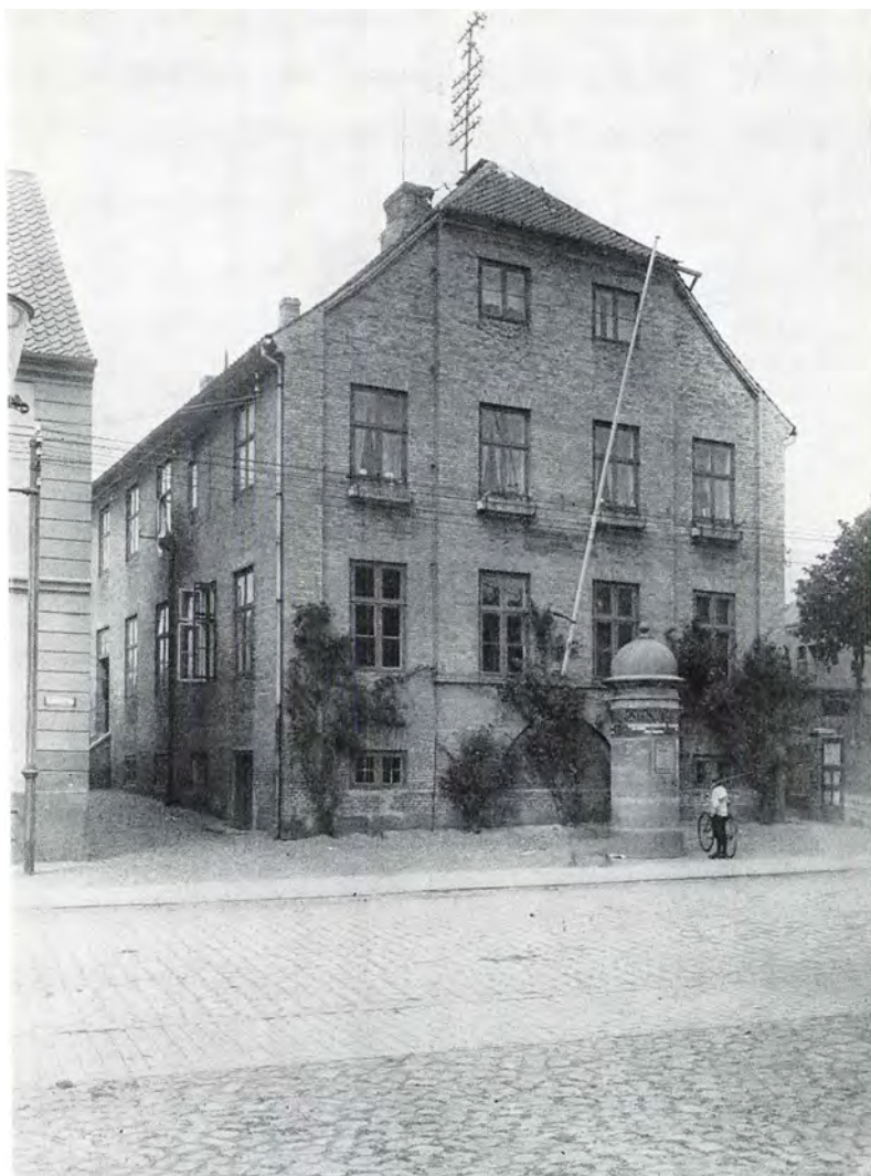
Frederiksskolen, Nørregade 41, foto graferet omkring 1930, er opført som pendant til og med samme indretning som Wilhelmineskolen. Bygningen var i brug som skole indtil 1940'erne og er idag Haderslevs bagård.
