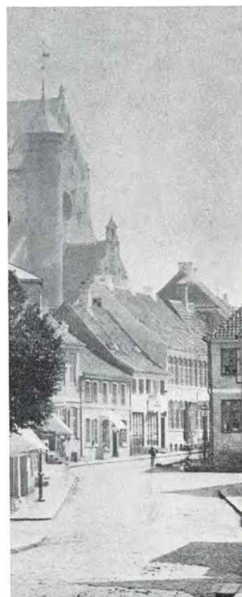
Bispegade 6, den høje toetagesbygning, der stikker frem bag hushjørnet til højre. Det er et meget læst hus, som endnu eksisterer, dog med store forretningsvinduer i stueetagen. Nr. 8 er fra 1779, nr. 10 fra 1850'erne og nr. 12, der stikker frem bag træerne til venstre, er som nr. 6 fra 1840'erne.
