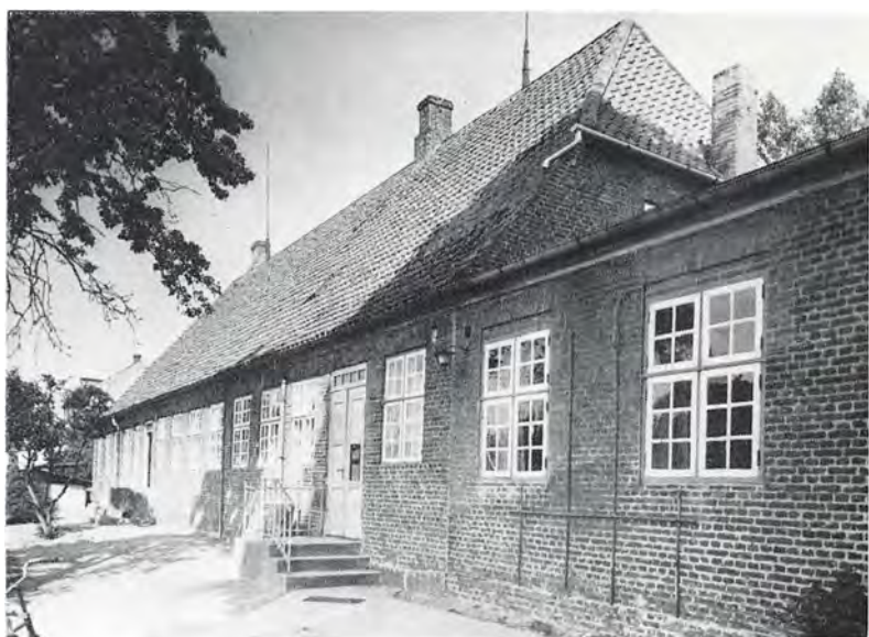
Øegneskolen i Gl. Haderslev, beliggende Slagtergade 66, opført 1826–'7. I forgrunden en senere tilbygning. Bygningen fungerede som skole indtil 1924.
