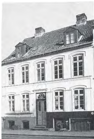
Toregade 65, opført 1852 af handkemager Andr. N. Kruse, et af de mukkeste og mest velbevarede huse byen fra denne periode.
