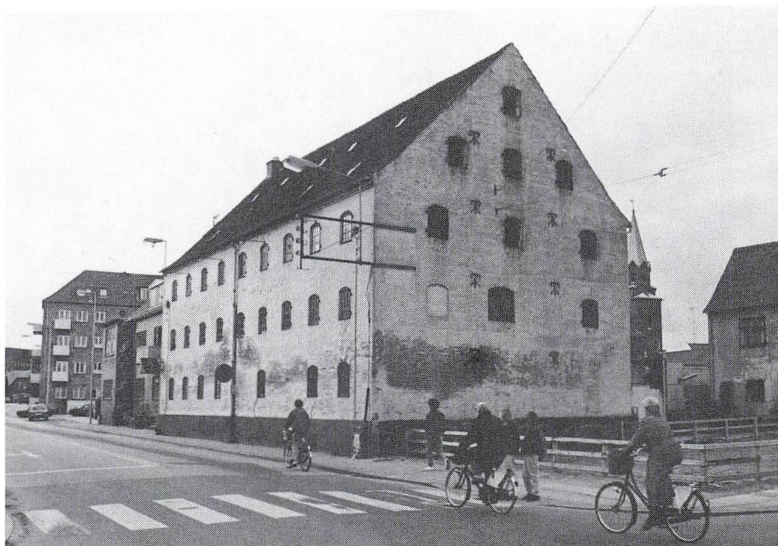
Jernbanevej – pakhuset. PK fot.
