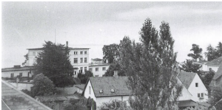
Udsigt fra "Radisen" mod øst. Den store bygning er det daværende hotel "Gefion", der blev nedrevet i 1960. Billedet er fra 1956.
