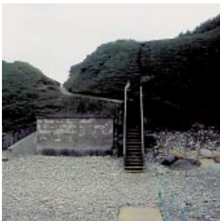
Det tidligere redningshus og trappen ved »Slugten« til stranden Foto: Knud Brøns
