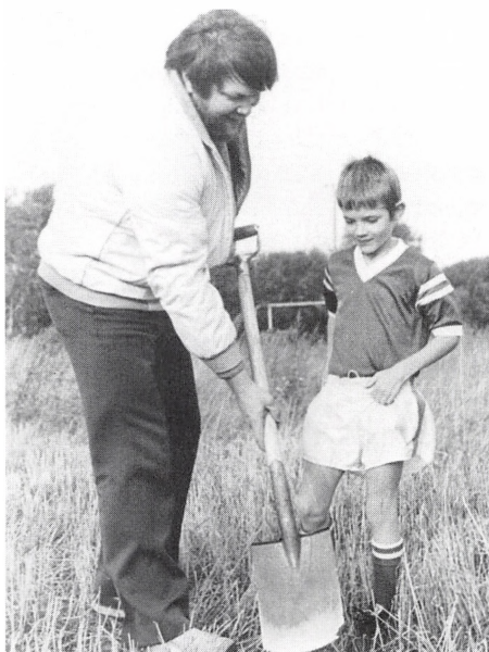
Peer Seierby hjælper pustingspilleren Ronny Larsen med det første spadestik til de nye baner.
