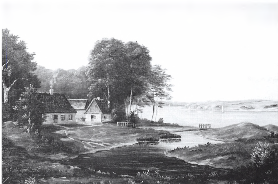
Mølleåens udløb fra Furesøen med det i teksten nævnte stemmeværk. Det var anlagt i 1650 og fandtes til 1888. I starten havde det funktion som spærring, mens møllebygningen blev bygget. Siden var det sikkerhed mod oversvømmelse. I baggrunden ses skrænterne i Virum (senere Kaningårdskvarteret) og Bistrup. Maleri af T. Schmidt 1872. Byhistorisk Samling
