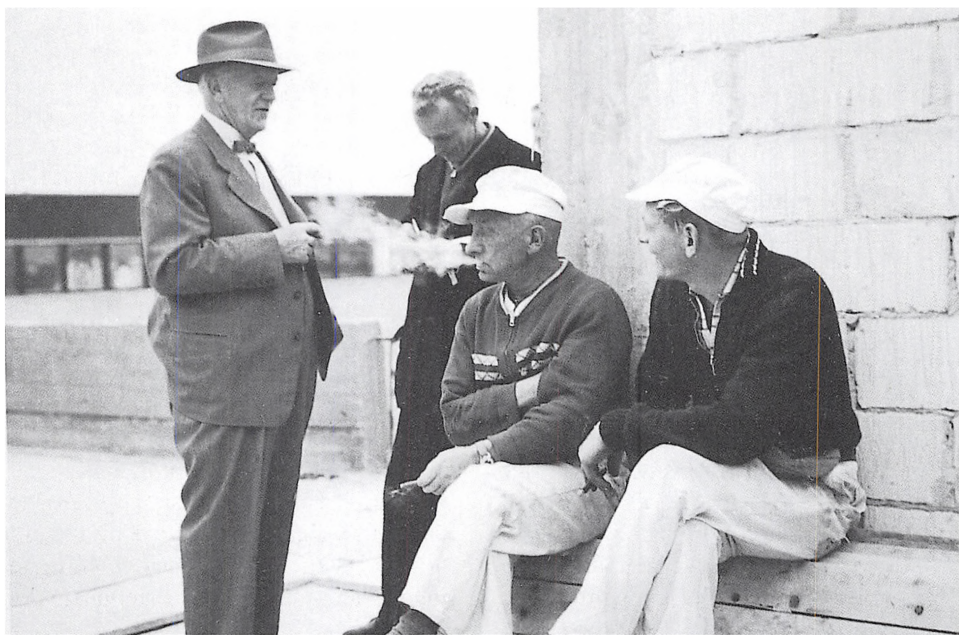
Tømmerhandler Johannes Fog i en karakteristisk situation - i samtale med håndværkere - på taget af Kgl. Brands nybygning (Lyngby Hovedgade 47) i 1961. Byhistorisk Samling
