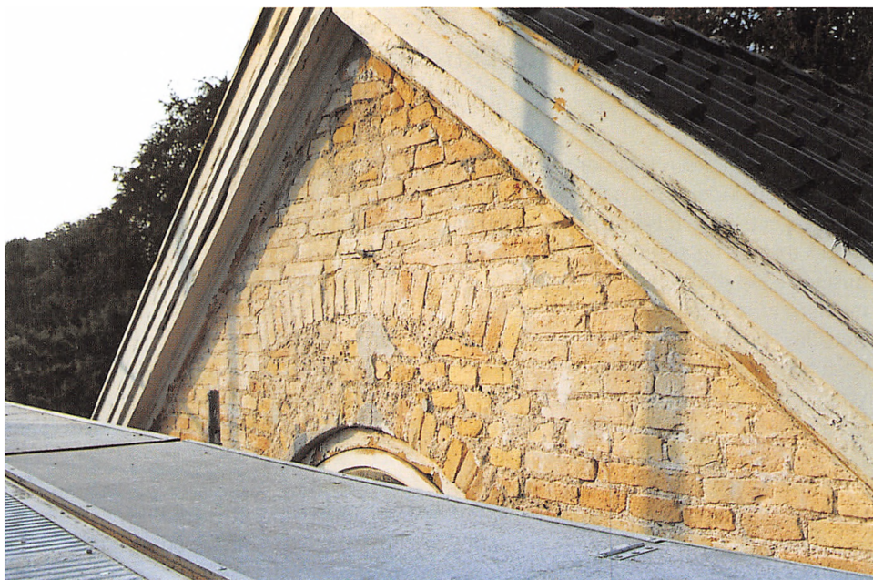
Frieboeshvile i sommeren 2003. I hovedbygningens kvist mod gården sidder et halvcirkelformet vindue; men sporene i muren viser, at der oprindeligt har været en luge ind til loftet med en hejsbom over, således at man har brugt loftet til opbevaring.
