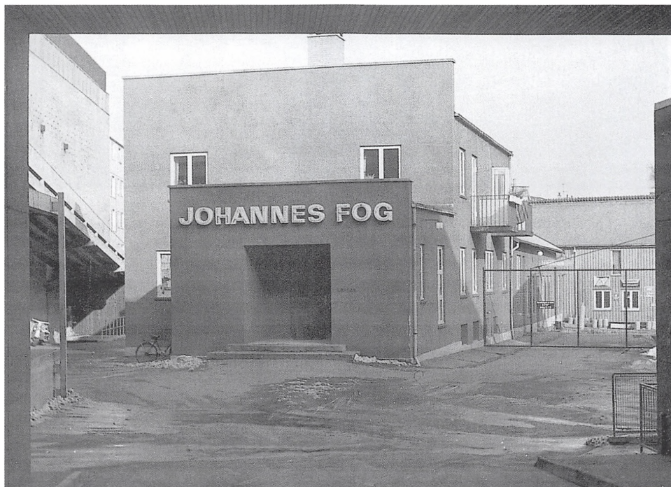
Indkørslen til tømmerhandelen gennem porten i den nye bygning Lyngby Hovedgade 47 fra 1962. Til venstre ses lidt af Magasins første bygning fra 1961, der havde opkørsel til parkeringspladser i øverste etage.
