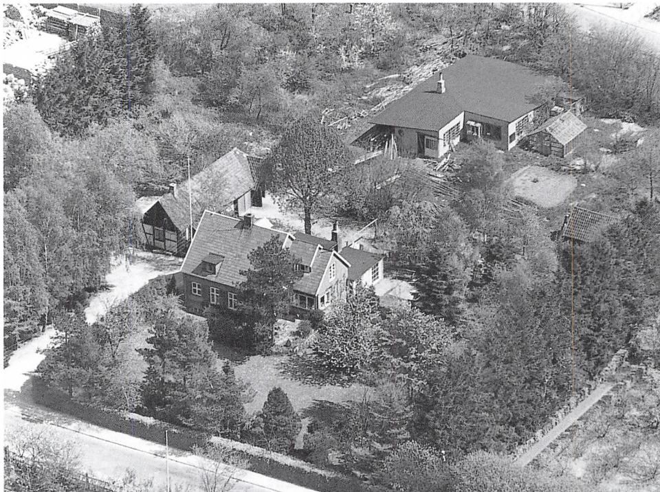
Mit barndomshjem i 1950'erne. Stuehuset ligger mod Hjortekærvej og garage/udhus til venstre. Tømrerværkstedet med lageret bagest og rundsaven er i venstre side.
