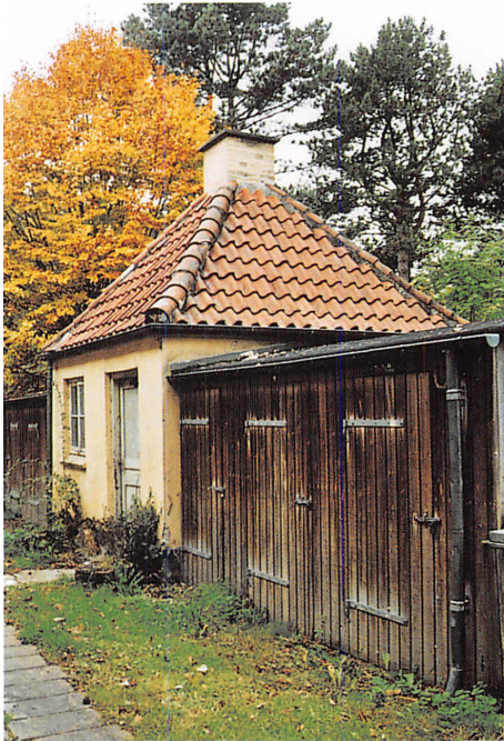
De gule huse havde fra starten indendørs toiletter; men desuden var de forsynet med vaskehuse og skure.
