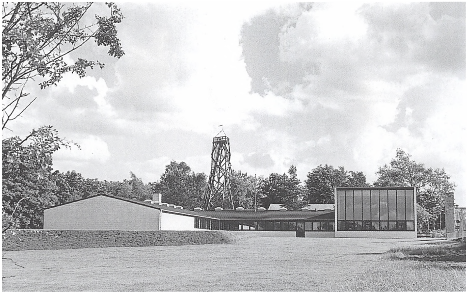
Foto af det præmierede byggeri 1969.
