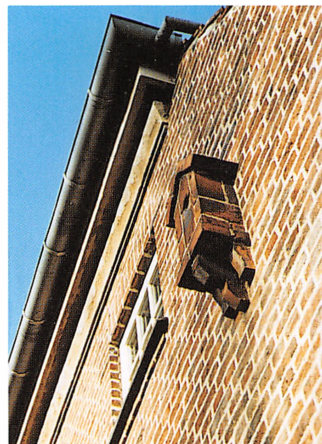
Muret størekasse på gavlen af Lundtoftevej 53.
