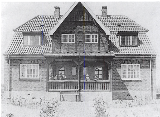
Lundtoftevej 57 i 1926. Dengang var bindingsværket i den store kvist stadig synligt, og de overdækkede verandaer foran hoveddørene var åbne.
