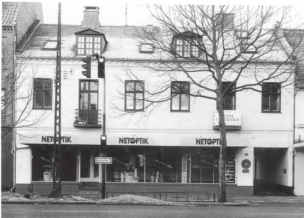
Lyngby Hovedgade 56. Forhuset er opført i 1883 som skole- og beboelsesbygning.
