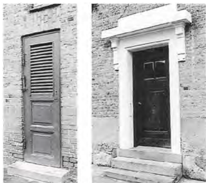
Karakteristiske døre i »Belgien«, facade og bagside (oprindeligt toilet med adgang fra gården). Bemærk de dekorative »sylvdsten« i facaden.
