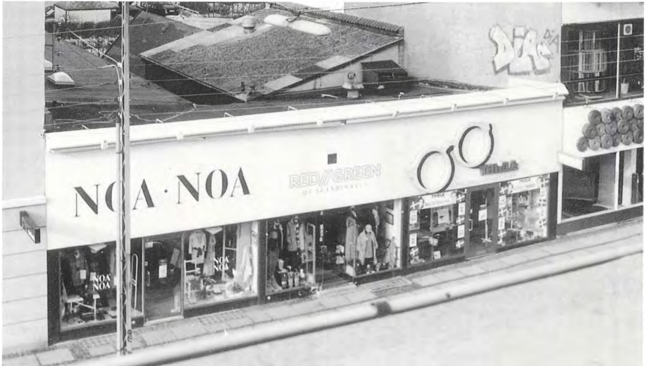
Lyngby Hovedgade 66 A, opført i 1929 og senest ombygget i 1991. Forhuset måler 16 x 9 meter, den nordlige sidebygning 20 x 6 meter og den sydlige sidebygning 18 x 7 meter (med en tilføjelse på 2 x 3 meter på vestgavlen).
