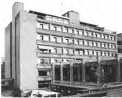
Plejehjemmet Møllebo set fra nordvest. Til venstre den nye hotelfløj fra 1970, til højre mellembygningen med køkken og spisesal (ligeledes fra 1970).
