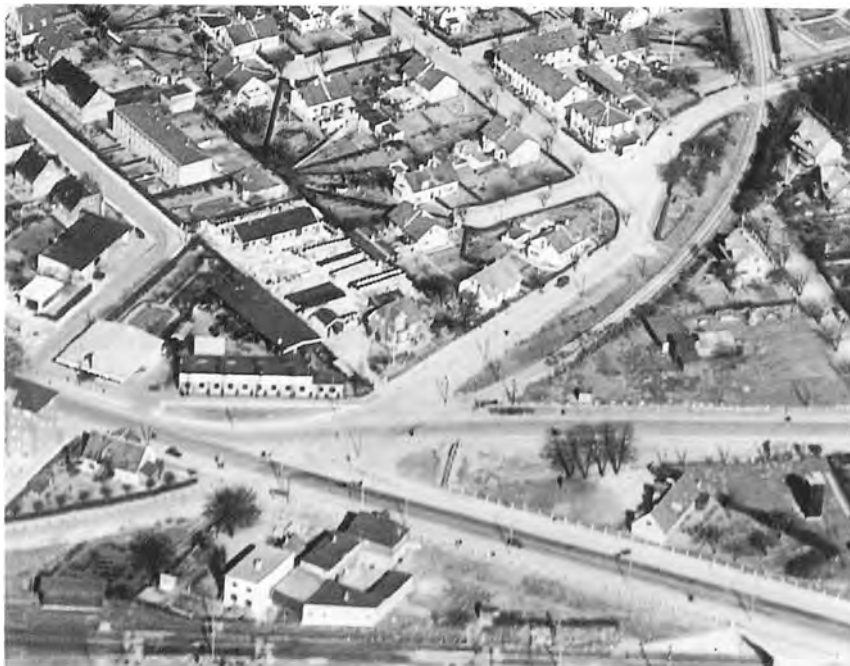
Hovedgaden 88 A m.m. i 1936 (udsnit af luftfoto set fra vest). Nederst ses S-togslinien med viadukten under Hovedgaden længst til højre. Lige over bygningerne ses Hovedgaden og Jægersborgvej med Nørumbanens krydsning, som nedlagdes samme år. Midt i billedet ses til venstre Hovedgaden 63 (Th. Jungersens autohandel) og til højre brandstationen. Billedets øverste del viser en del af byggeforeningen »Frem«s huse.
