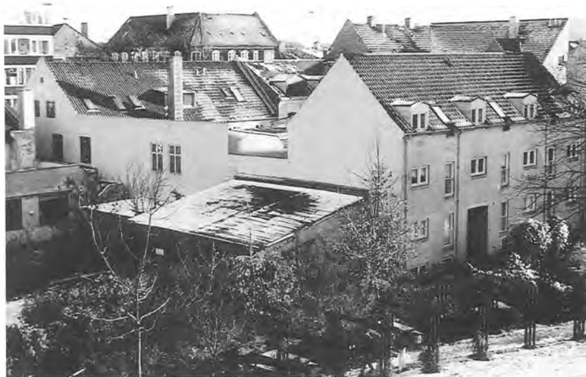
Hovedgaden 54, side- og baghus set fra bagsiden.
