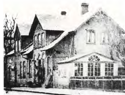
I 1859-60 opførtes et af de første villakvarterer, Rosenvænget i København. Otte år efter byggede murermester Schumacher de to første villaer på Hovedgaden, nr. 30 og 32 (underst).
