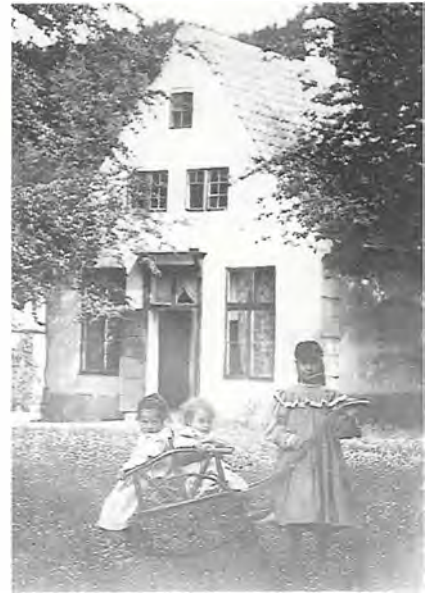
Sidebygningens gavl i 1897 med døren ind til havestuen. Kvadrene på muren til højre langs gavlkanten svarede til portfacadens kvadre.
