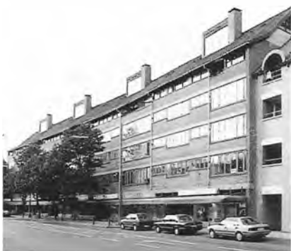
Nygård, nr. 57, har trods sin længde og højde en varieret facadeudformning med forskellige vinduesopdelinger. Det høje tag er elegant udformet med svejf og trappe- og gavlvinduer. Huset optager Hovedgadens drejning med et lille knæk på midten.
