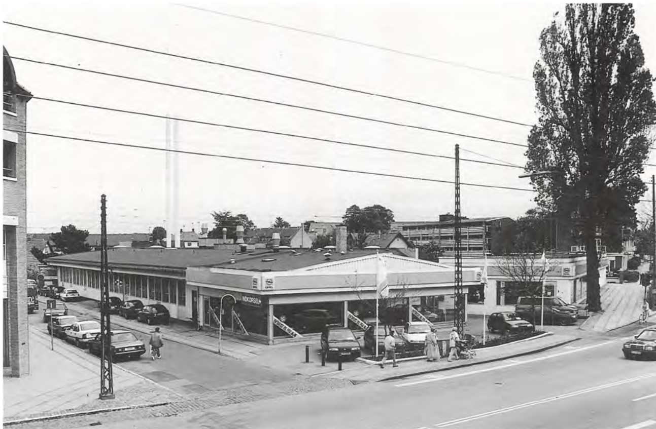
Lyngby Hovedgade 63, som komplekset fremstår efter ombygningerne i 1985-87. De ældste dele af bygningerne stammer fra 1925.
