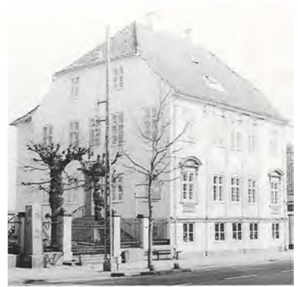
Det Hvide Palæ, opført i 1806 som et udlejningslandsted med ialt fire etager, inspireret af Harsdorffs palæer i tidlig klassicistisk stil med pilastre og segmentfrontoner.
