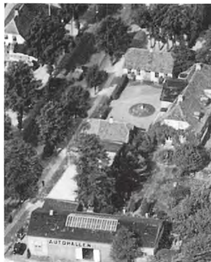
Hovedgaden 57, udsnit af luftfoto fra slutningen af 1930'erne. Øverst Nygård med sidelænger, nederst bilhallen ud til Nygårds Allé.
