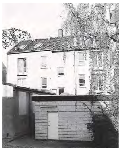
Hovedgaden 62 set fra bagsiden med en smal gang imellem de to sidebygninger fra 1941 og 1974.
