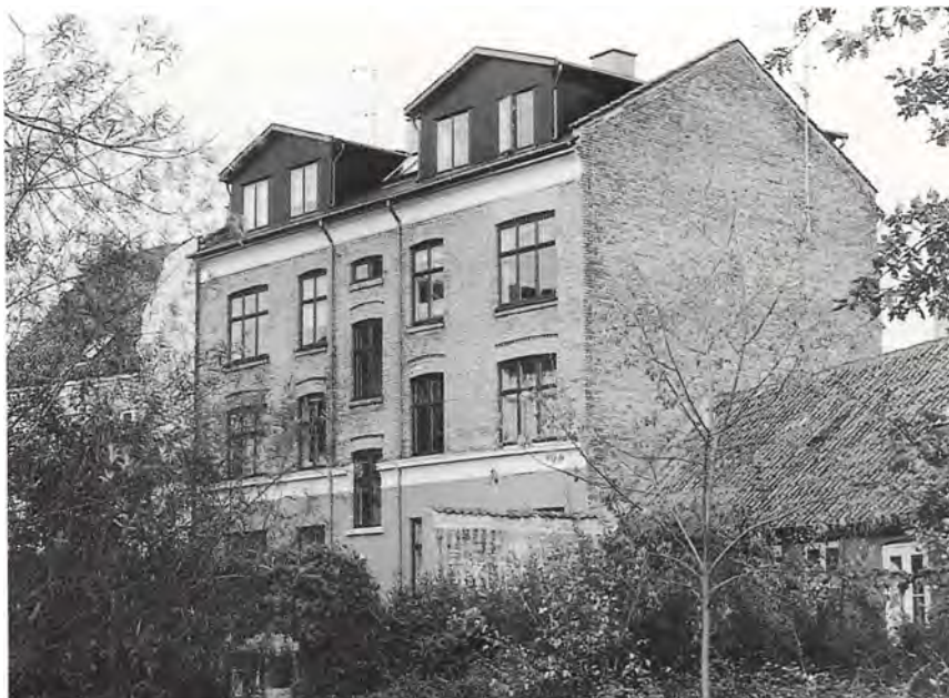
Baghuset til Hovedgaden 44, opført i 1893 med kvistlejligheder fra midten af 1980'erne.
