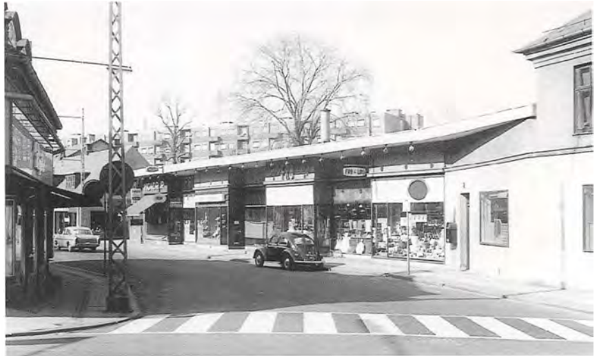
Hovedgaden 38, basarbygningen fra 1935 langs Jernbanevej. Niels Wivel fot. 1966.
