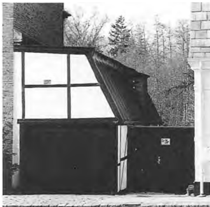
Fra opførelsen i 1903 til nedrivningen i begyndelsen af 1990'erne var staldbygningen en karakteristisk del af Lyngby Hovedgade 8's fremtræden mod Kongevejen, opført i bindingsværk op til gavlen af nr. 8 A.
