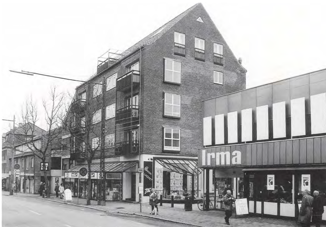
Lyngby Hovedgade 17, opført i 1935 og renoveret i 1980.
