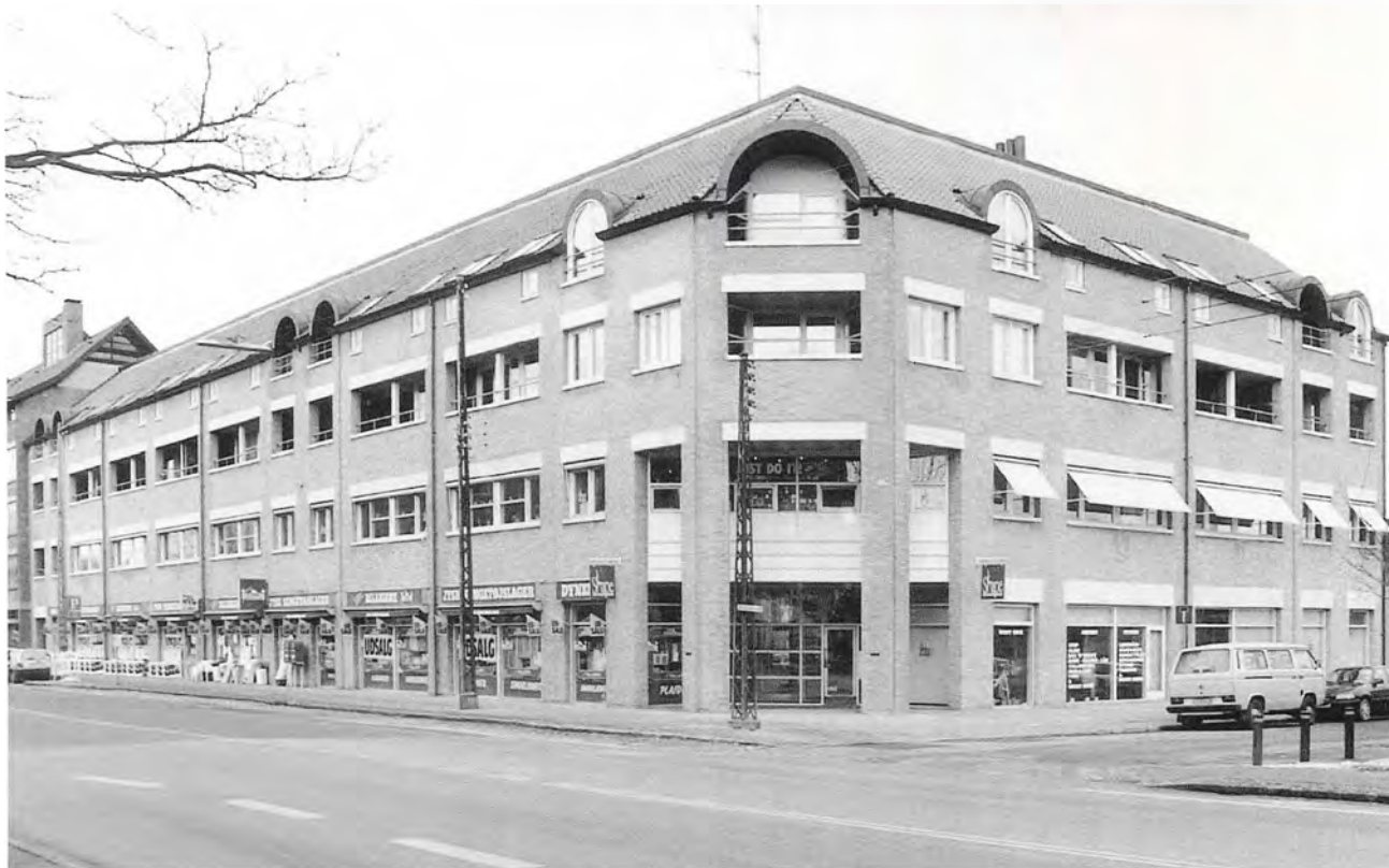
Lyngby Hovedgade 59-61 er opført i 1988. Den høje indgangsportal og de rundbuede kviste er typiske for den postmodernistiske stil. Lige til højre for dobbeltkvisten midt på facaden anes det lodrette fremspring i muren, som markerer delingen mellem nr. 59 og 61.
