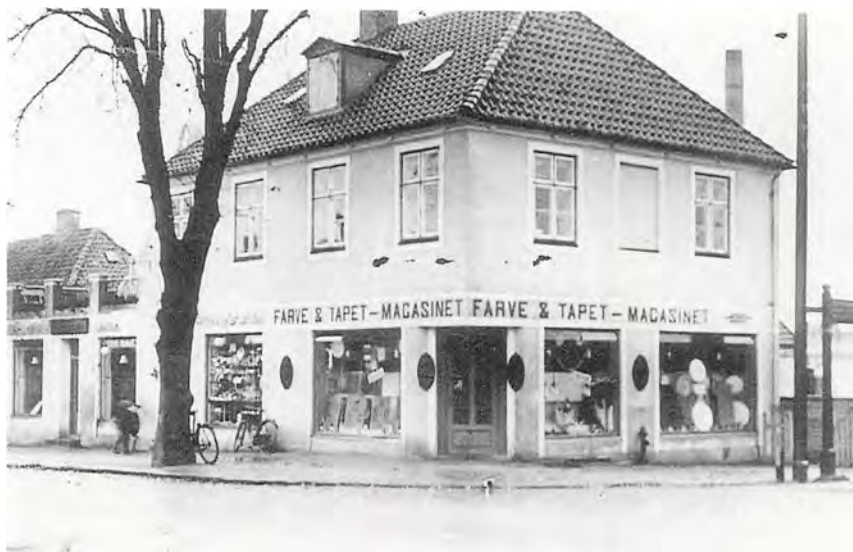
Hovedgaden 51, hjørnebygningen som nyopført i 1926.
