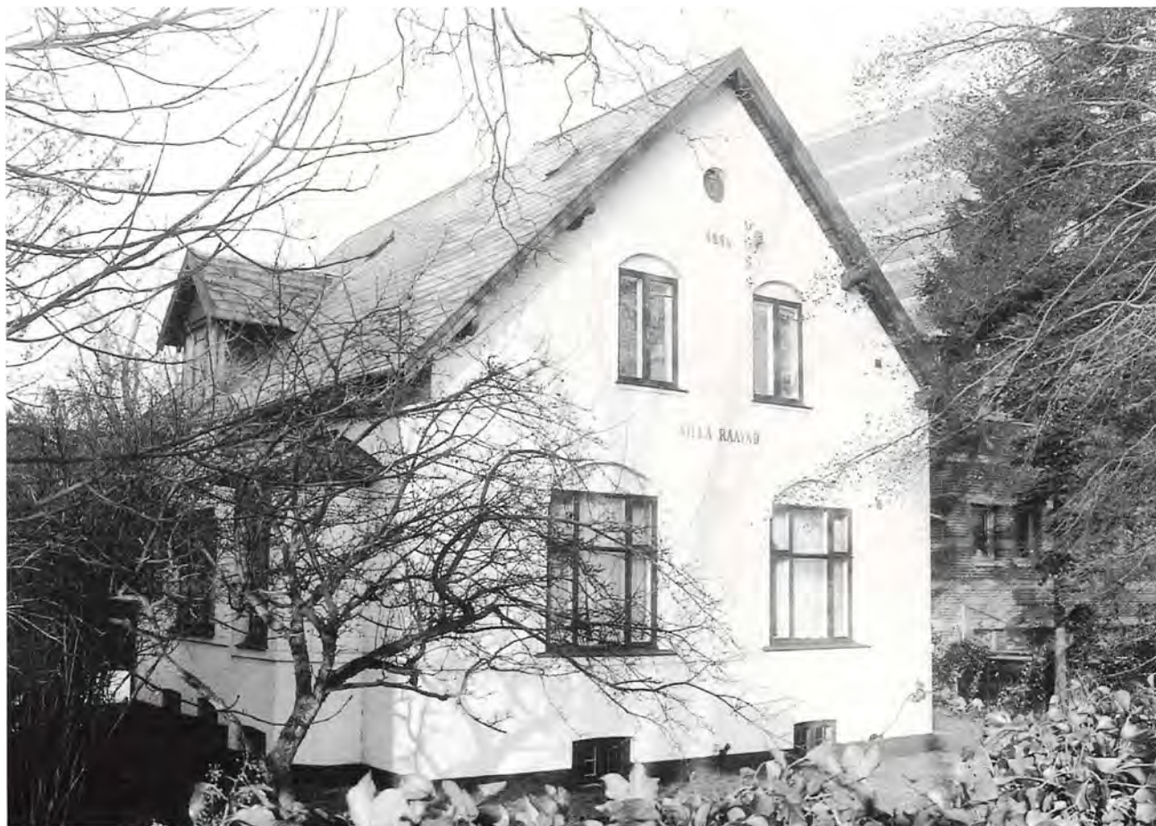
Lyngby Hovedgade 100-102, Frobenius' orgelfabrik, består af Villa »Raavad« fra 1896 og den samtidige fabriksbygning bagved, udvidet i 1926 og senere.
