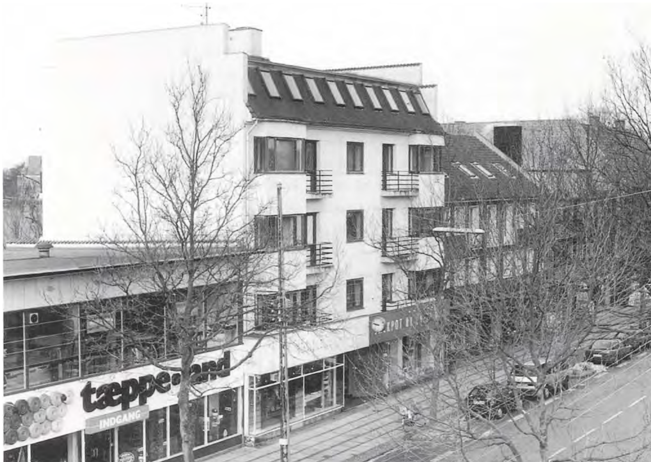
Lyngby Hovedgade 64 er opført i 1932 i funktionalistisk stil. Bygningen havde oprindeligt blank mur med skiftevis gule og røde mursten i vandrette bånd (jfr. farveillustrationen side 29).
