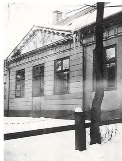
Detalje af »Kandidat Jensens hus«, Hovedgaden 33, i 1929 kort før nedrivningen.
