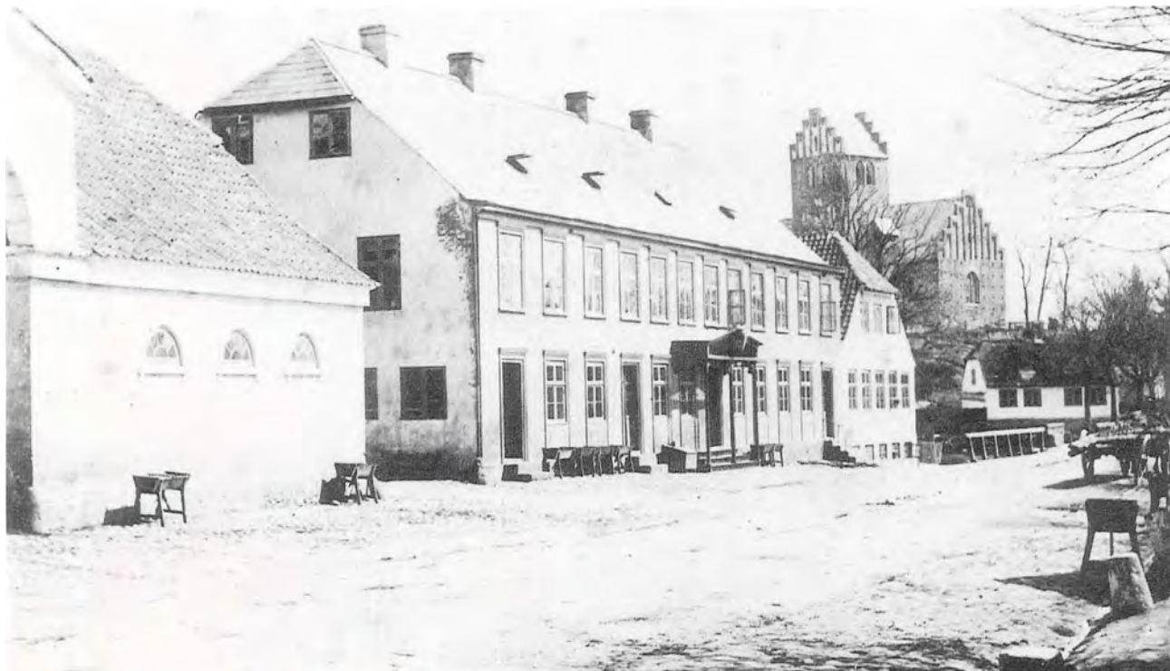
Store Kro i 1860'erne. Til venstre rejsestalden fra 1832, i midten hovedbygningen fra 1845 og til højre gavlen fra 1850 af sidebygningen langs Mølleåen.
