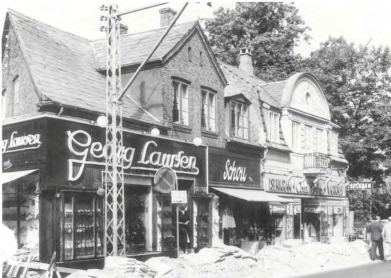
Lyngby Hovedgade 32 (til venstre) og 30, fotograferet af Gunnar Jørgensen 1958. Butiksfacaderne er nu helt beklædt med skilte, paneler og udhængsskabe. - Se også farvebillede side 21.
