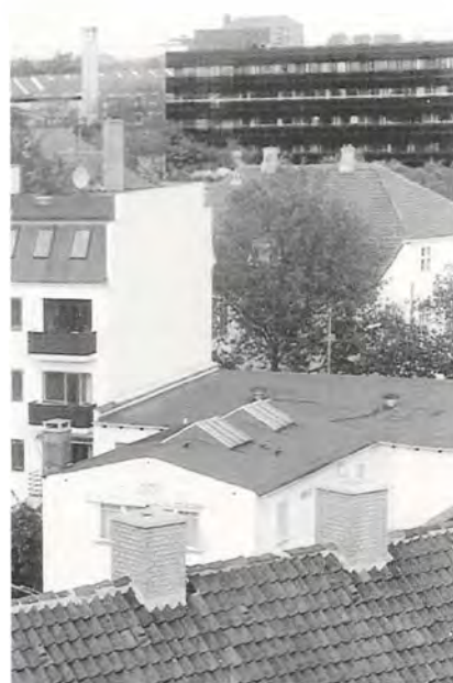
Hovedgaden 66 set fra bagsiden med tilbygningen.
