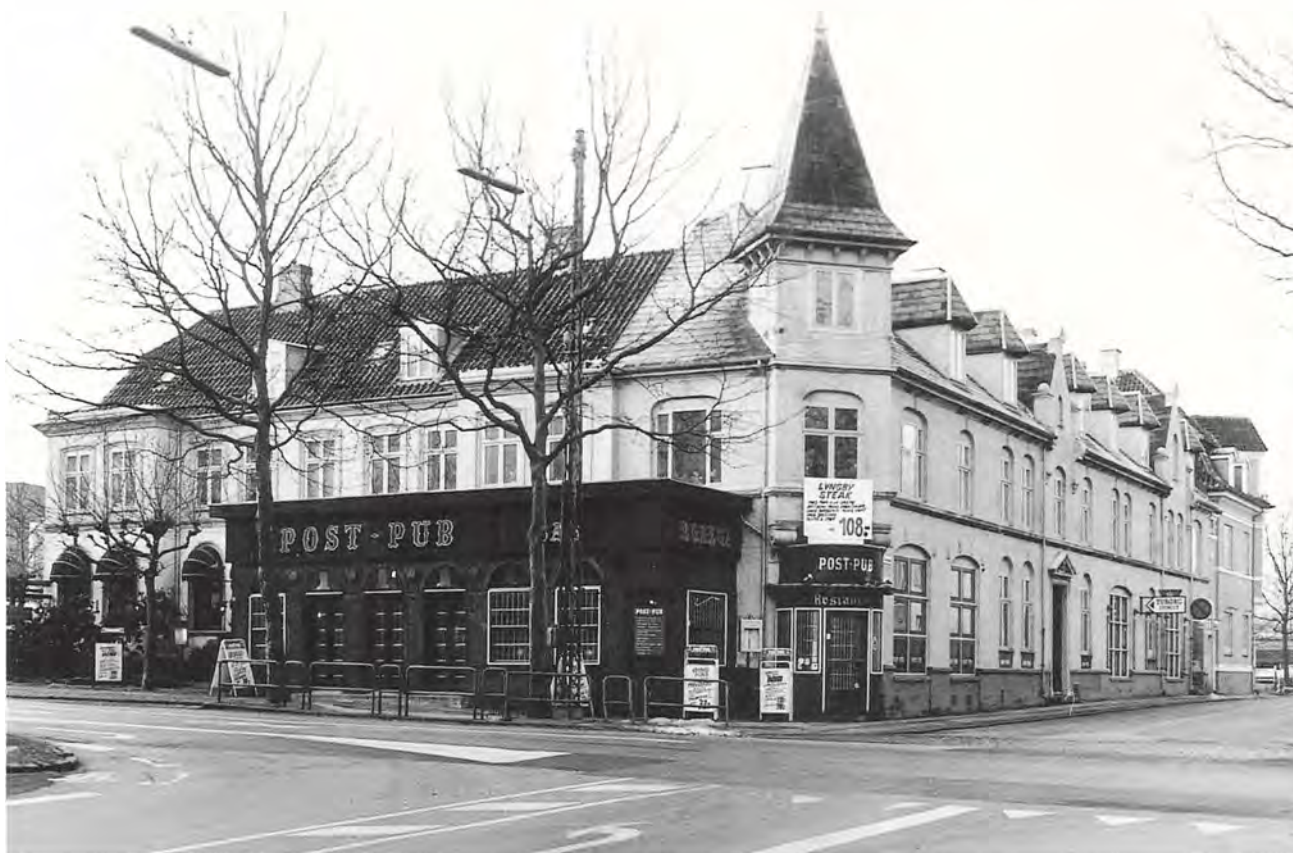
Lyngby Hovedgade 78. Fløjen til venstre langs Hovedgaden er opført i 1860. Hjørnet og fløjen langs Gammel Jernbanevej er opført i 1897.
