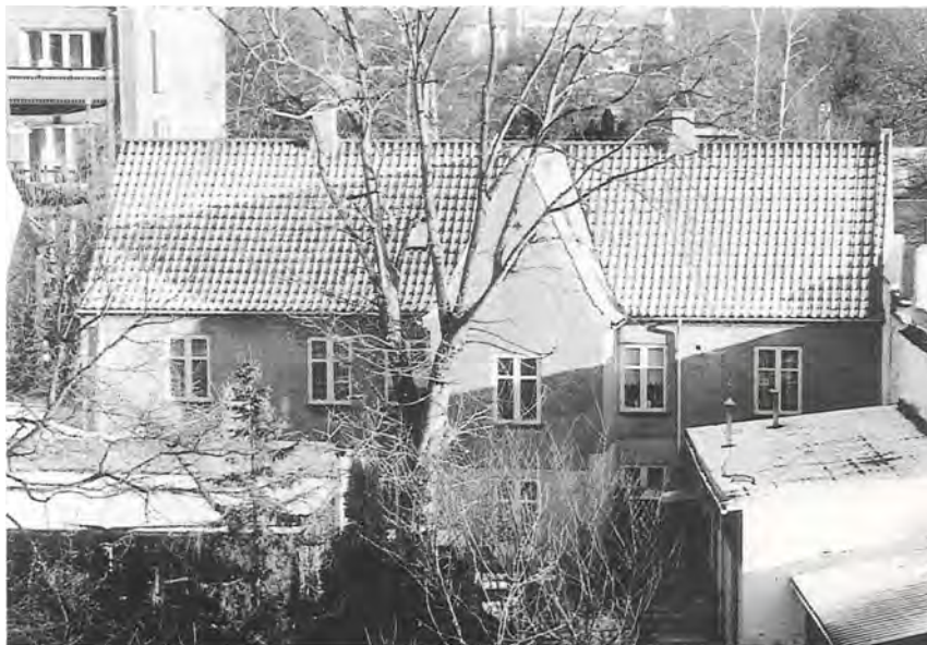
Lyngby Hovedgade 48 set fra bagsiden med baghus og sidehus.
