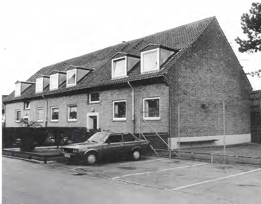
Hovedgaden 95, blok med 8 lejligheder.
