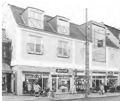
Hovedgaden 70 A, opført i 1989 over en basarbygning fra 1937.
