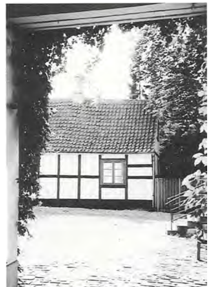
Den nordlige del af Baghusets gårdfacade set gennem porten. Denne del af bygningen fik bindingsværket udskiftet i 1989.
