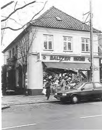
Tilbygningen Hovedgaden 49 A, opført i 1914.
