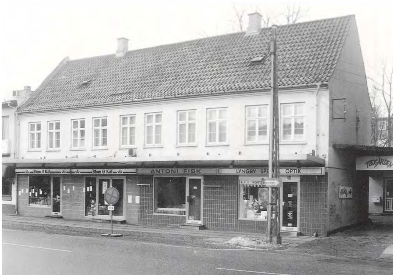
Lyngby Hovedgade 48 er opført i 1832 og forhøjet til to etager i 1924.
