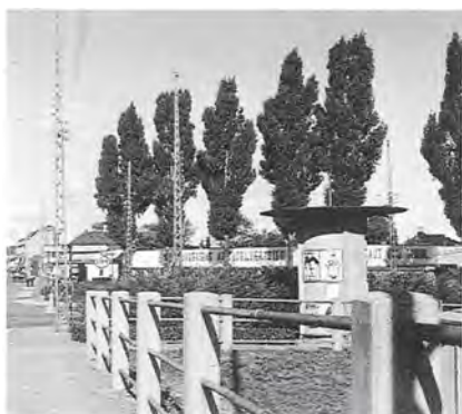
De seks popler, som var plantet i 1926-27, var et vartegn for den sydlige del af Hovedgaden. De dominerede totalt bilforretningens lave facade, og dette var årsagen til fældningen af de fire midterste i 1965.
