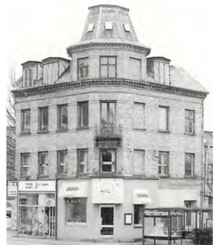
Tårnborg, nr. 36, blev opført i 1887 ved den nyanlagte Fæstningskanal som en forhøjelse af en ældre toetages ejendom. Arkitekten Viggo Klein var tydeligt inspireret af to nyopførte bebyggelser i København, Søtorvet og Gammelholm (øverst). (Efter Millech & Fisker, Danske Arkitekturstrømninger , 1957).
