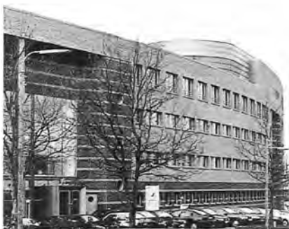
To kontorhuse, der repræsenterer en udvikling i størrelse og dominans. Nr. 47 er opført i 1962 som en mellemstor forretningsejendom i den internationale stil, mens nr. 94-98 fra 1994 med sin 180 meter lange facade er udtryk for tidens entreprenøropførte udlejningsbygninger.
