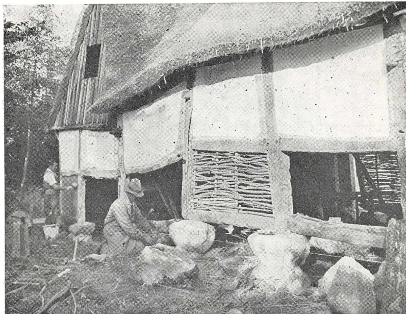
Fig. 12: Genopførelsen af den sjællandske gård fra Pebringe 1944. Ydervæggens sænkninger og hældninger, som var opstået i tidens løb, genskabes på museet. Man ser den grenfletning, hvorpå lerklining anbringes imellen stolperne.
